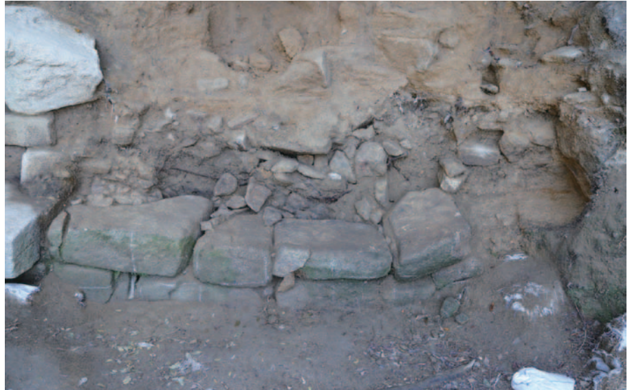
2. 東石塁 4 段目天端① (北西から)
