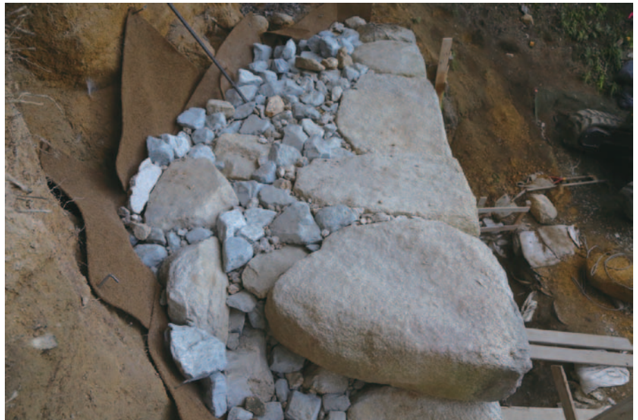
2. 裏込石充填完了(北東から)
