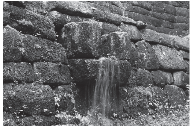
第 12 図 中門石壁の吐水口 (北東から)
