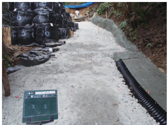
1. 仮設道路建設前(北から) 2. 土木シート敷設(北から) 3. 盛土(南から) 4. 排水管設置(北から) 5. 排水管理設(北から) 6. 吸出防止材敷設(北から) 7. グラウンドセル設置(北から) 8. 仮設道路竣工(北から)
