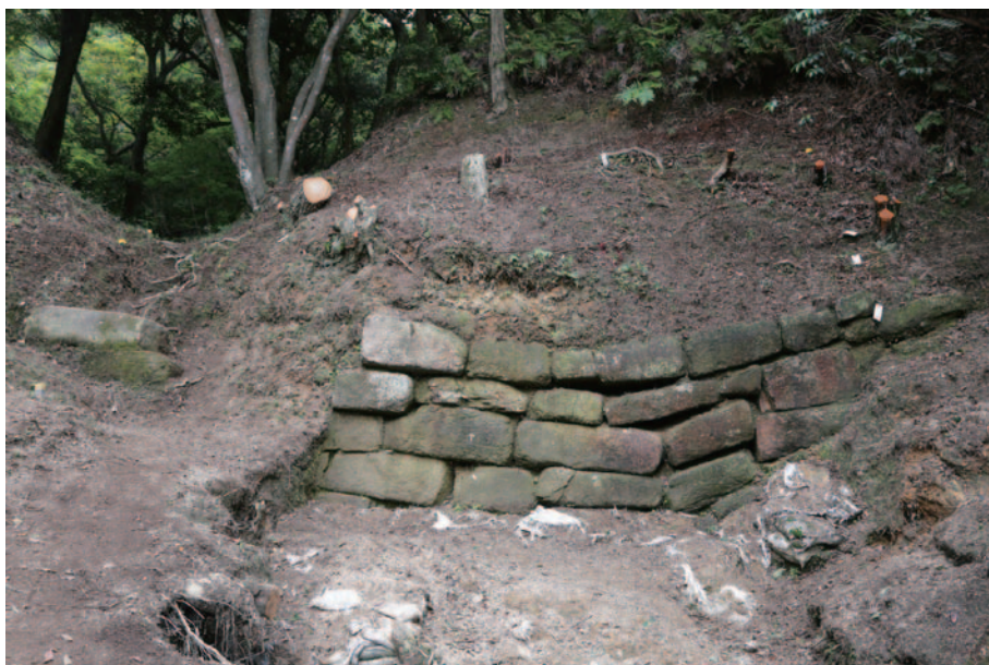
1. 東石塁調査前（北西から）
