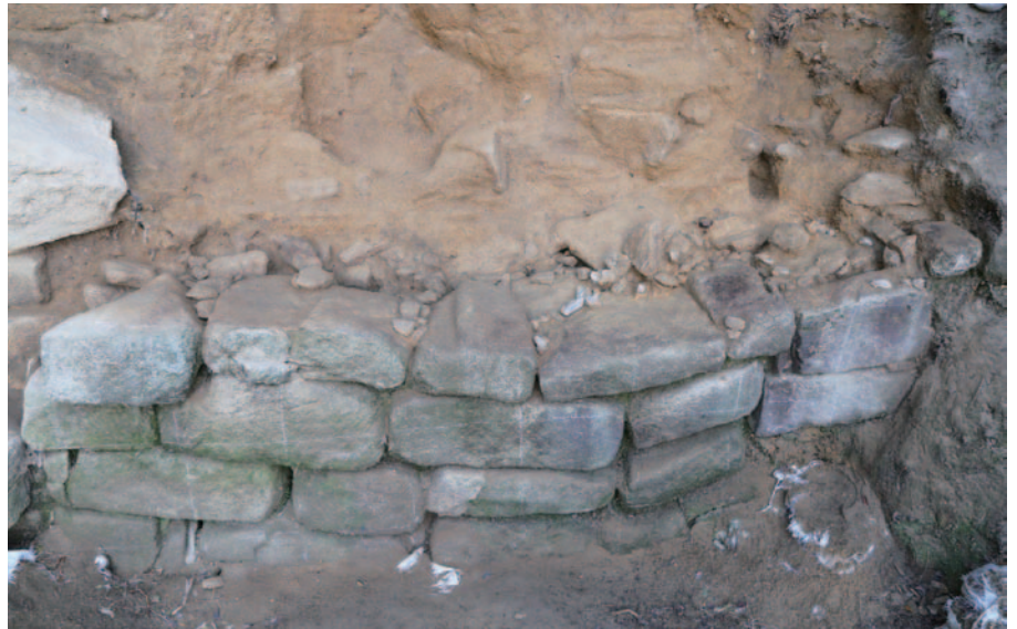
2. 東石塁 2 段目天端① (北西から)
