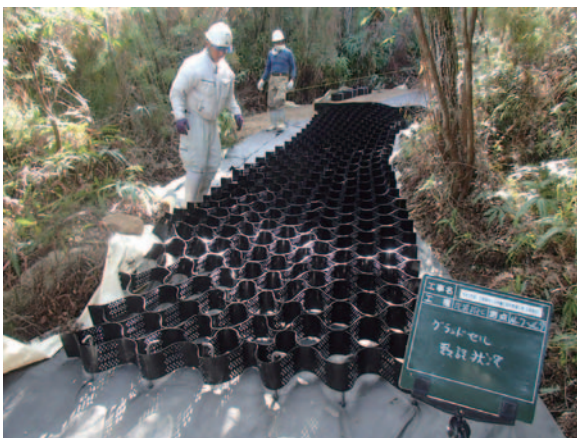
1. 仮設道路建設前(北から) 2. 土木シート敷設(北から) 3. 盛土(南から) 4. 排水管設置(北から) 5. 排水管理設(北から) 6. 吸出防止材敷設(北から) 7. グラウンドセル設置(北から) 8. 仮設道路竣工(北から)
