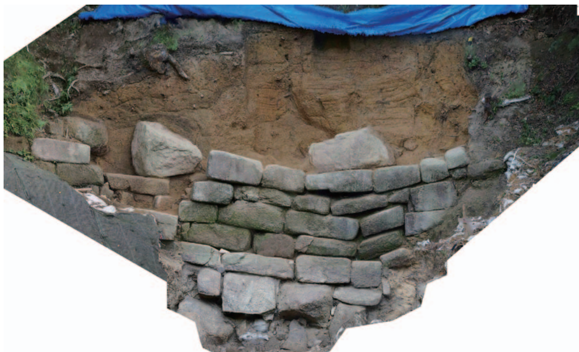
1. 東石塁解体前オルソ画像（北西から）
