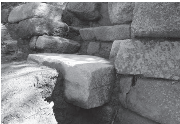
第 11 図 東石壁の吐水口 (西から)
