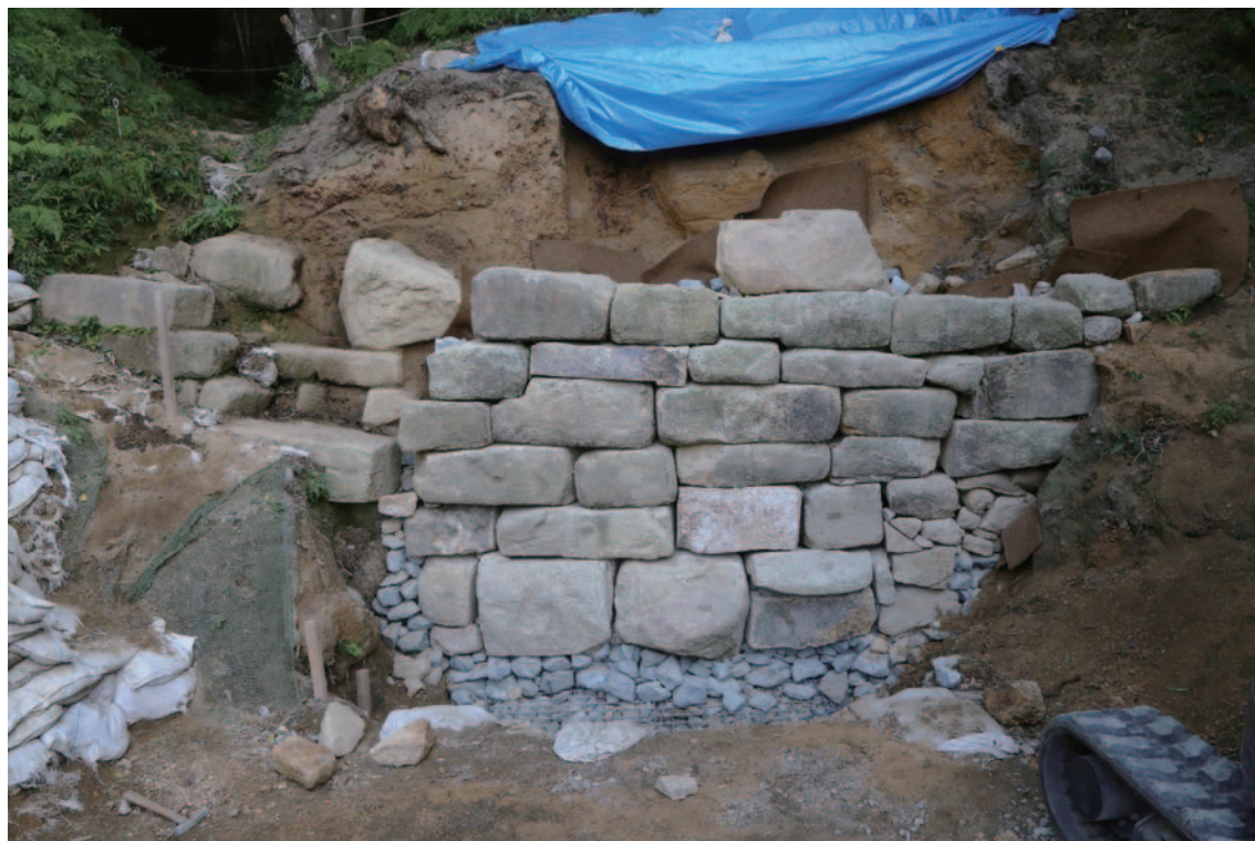
2. 東石塁積み直し完了（北西から）
