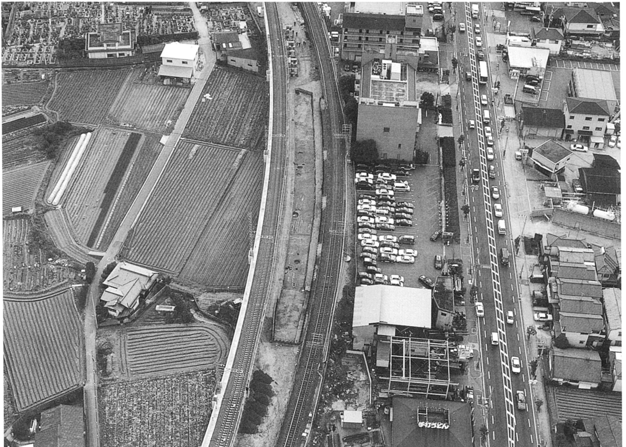
B区(北東から)
