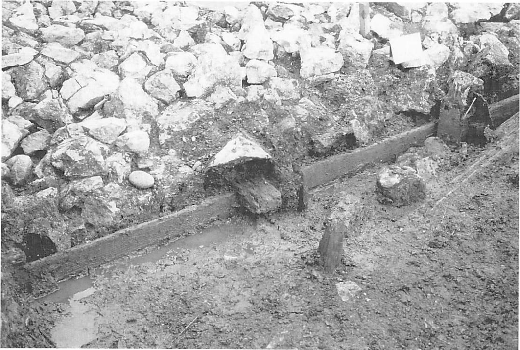
護岸石垣状況
