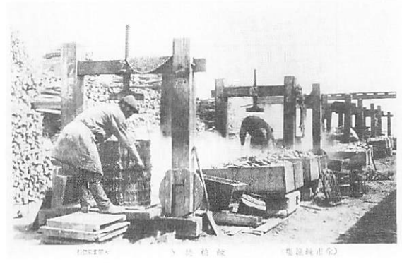
写真5 キリン(螺旋)式压榨器 佐藤利雄氏所蔵資料
