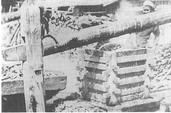
写真1 槓桿(テコ)式压榨器 大正期 余市地方
