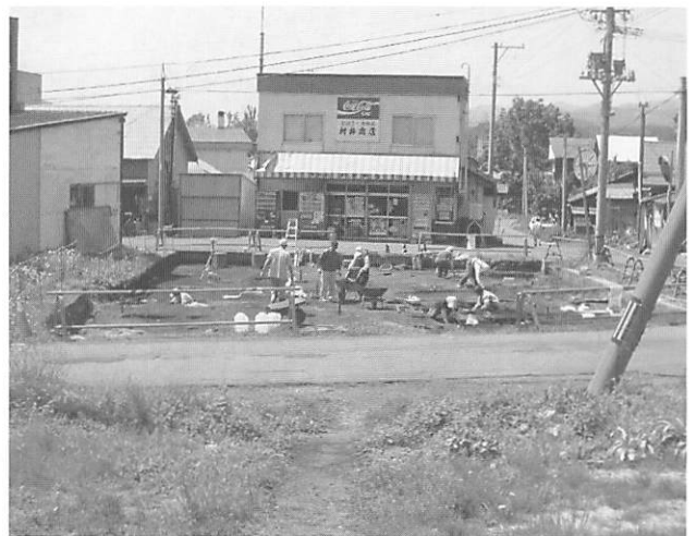
作業風景（北東→南西）
