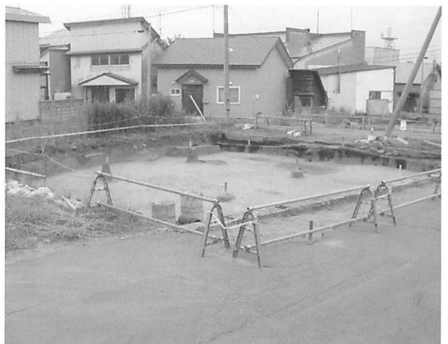
調査区南東側完掘状況（北→南）
