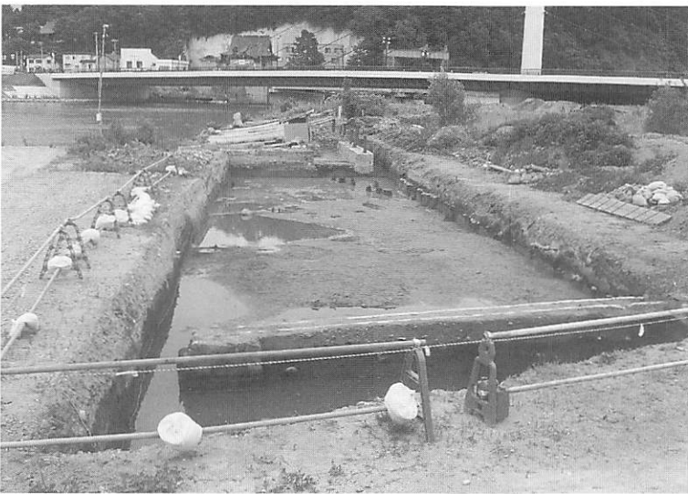
調査区完掘状況① (南→北)
