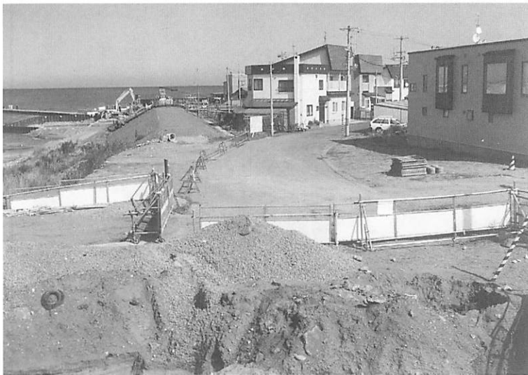
調査区遠景 (南西→北東)
