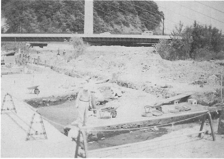
作業風景 (南西→北東)
