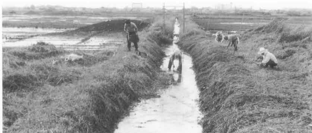
清掃作業状況(東より)
