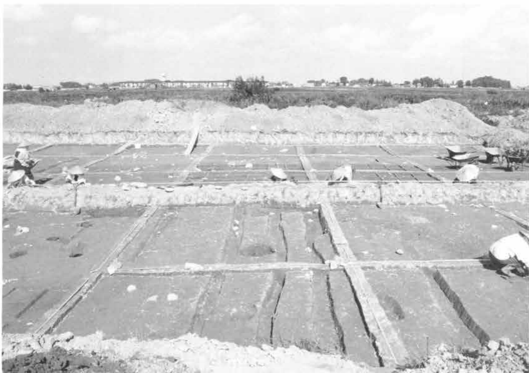
2、柴木A地点調査風景（南より）
