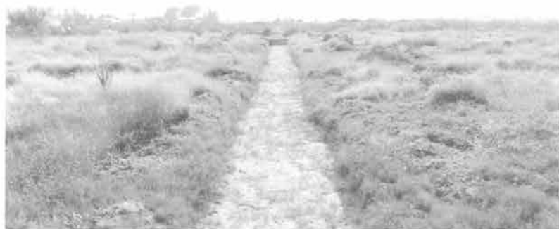
5、柴木B地点 北延張 トレンチの状況
