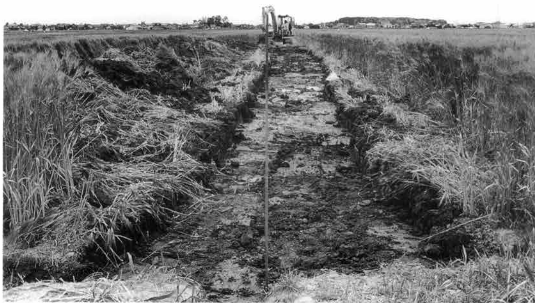
(1) 表土除去作業（南から）
