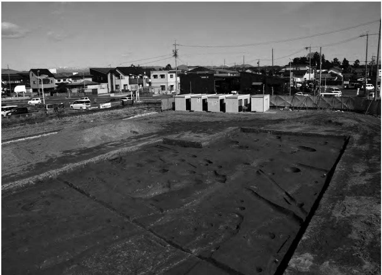
2 B区 完掘全景 (南西から)
