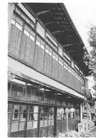
写真33 出し梁船柵造りの様子（本間富恵家）
