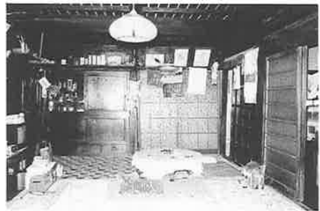
写真3 松下徳一家のザスキ（電灯の向こうに見える梁が長者柱と大黒柱間の梁である）
