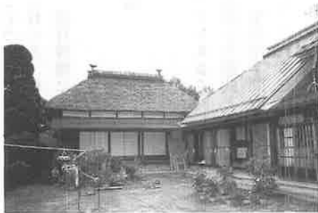
主屋(右手)の上手にある「トーデエ」 当初のトーデエはめずらしく往時の草葺屋根のままであった。(長谷川隆治家)
