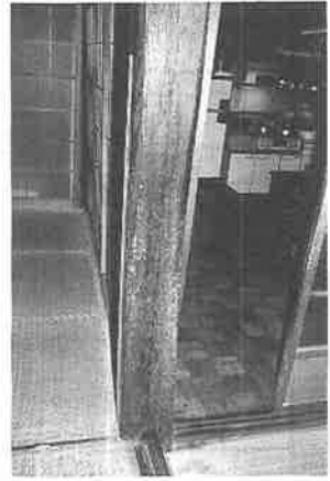
この大黒柱は「逃げなし」の状態 で据えてあるので、柱の角を欠いて畳を入れている (渋川広吉家)。
