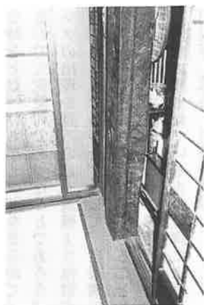
畳と敷居の間に「イタダタミ」を用いている。これは当初この室に畳を敷き詰めていなかったことを示す証拠である。
