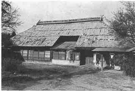
洪川益次家 (竜蔵寺町) 正面の屋根を切り上げたのは後の改造によるものである。また、屋根にトタンをかぶせたのは昭和30年代の終わり頃である。
