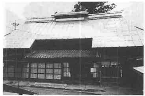
佐藤一三美家（鳥取町） 瓦葺きの庇部分およびヤグラの屋根も 昭和23年までは茅葺きであった。
