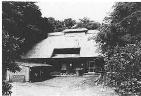
山田秋一家(小坂子町) 前面の「キリアゲニケエ」は建造当初からのものである。
