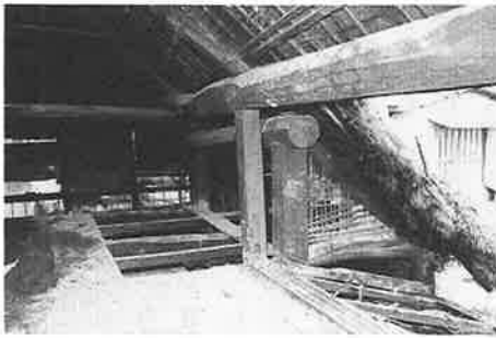
建造当初にあった桁（右側の木口の見えるもの）を切断し、そのすぐ上（左側）に新しい桁材を入れてキリアゲニケエを造り出しているのので、後の改造によく判る例である。（鈴木清家）。
