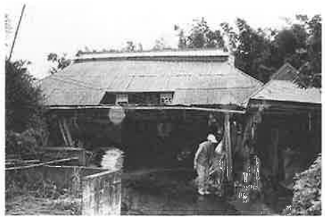
齊藤恵佐雄家（竜蔵寺町） 屋根前面の「キリアゲニケエ」は当初なし。
