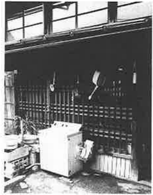
トブグチ(右端)の上手に今も残る「サマゴ」。この窓が低いのはこの内側で糸を曳いた姿勢(座操り器の高さ)に合わせたためである。また当地方ではこの窓を「イトザマ」とも呼称する(須田繁家)
