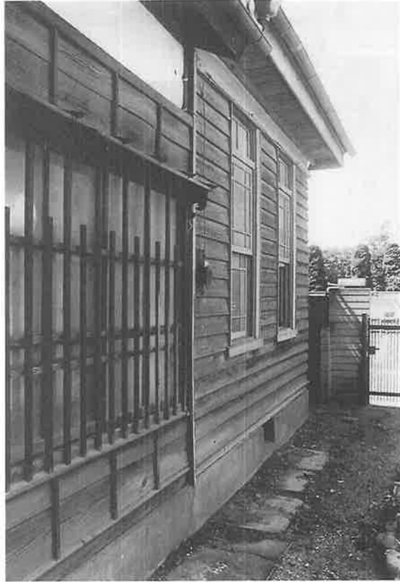
写真19 小島定子家（北側外壁）
