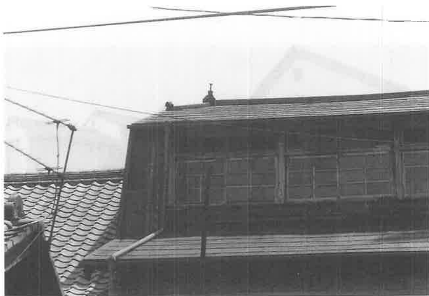
写真35 亀の湯 (浴槽、ダツイバ屋根)
