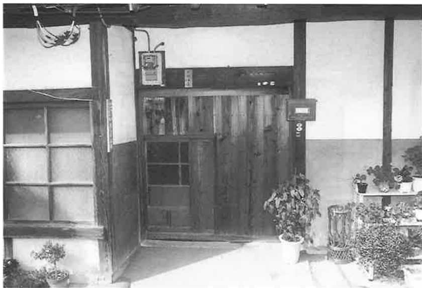
写真2 松村庫吉家（大戸一外側）
