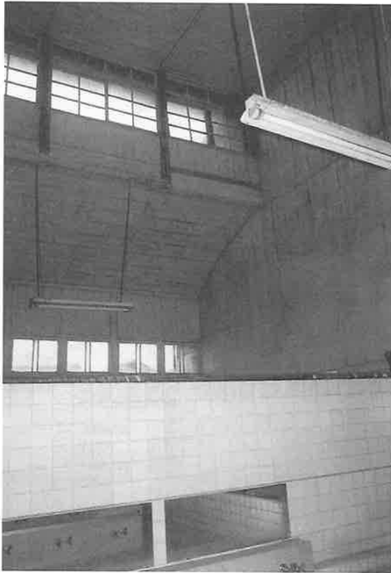
写真38 亀の湯 (中央部を高くした天井)
