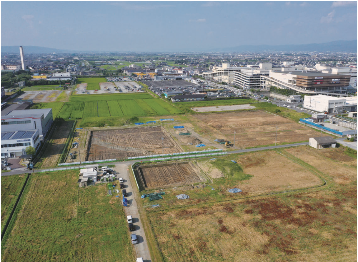
調査地全景 航空写真（南南西から）
