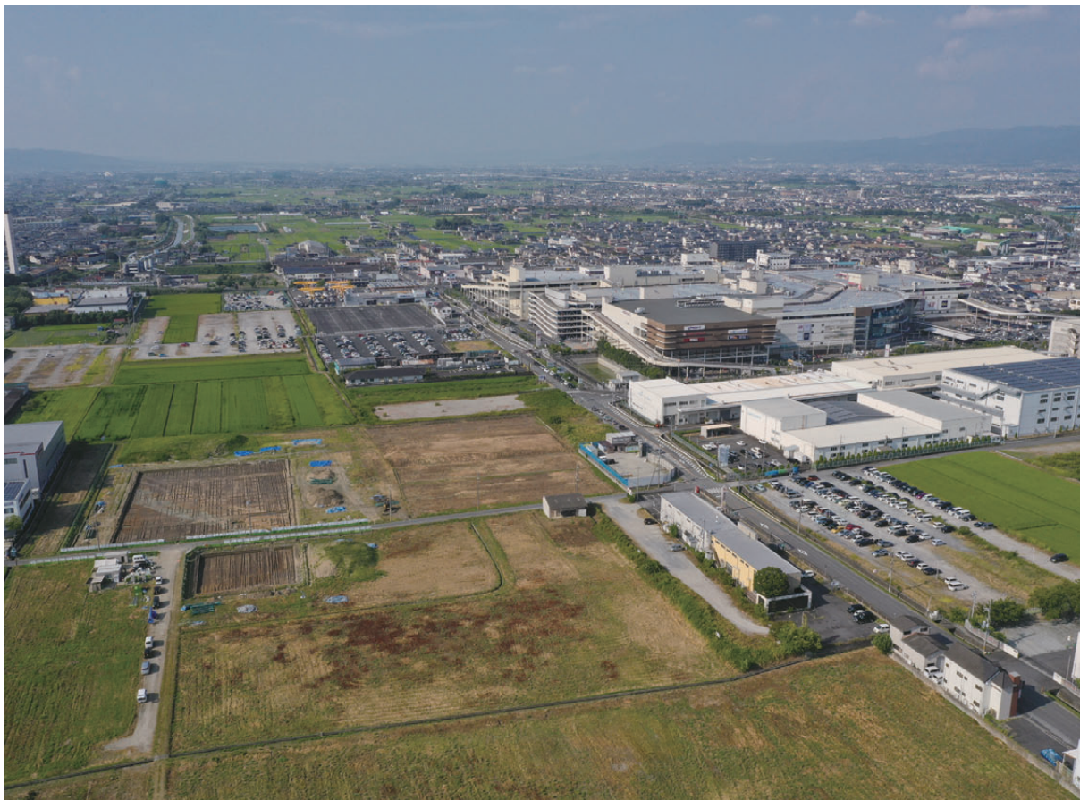
調査地全景 航空写真（南西から）
