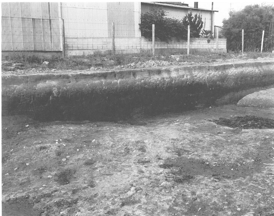
(1)S R01流路B土層断面
