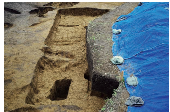
8. 331号住居跡掘り方(西から)
