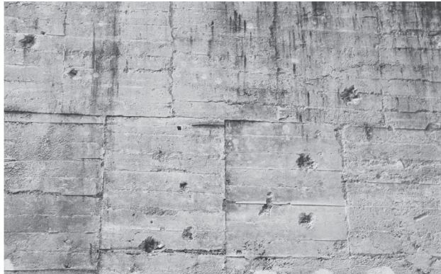
8. 掩体前壁の型枠跡と被弾痕跡
