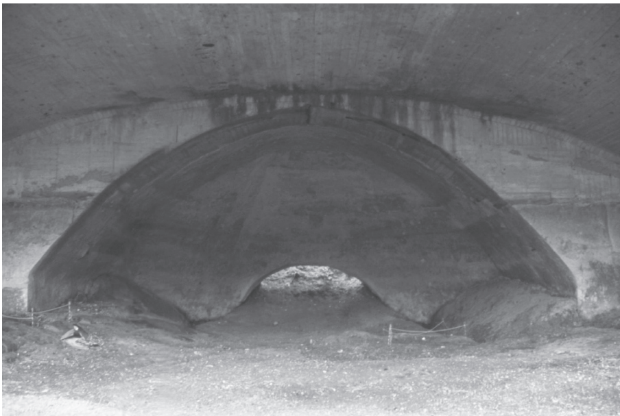
2. 調査前の掩体内(後部を望む) 後部開口部より土砂が流入していた
