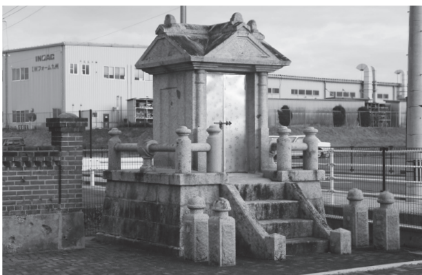
8. 旧仲津小学校奉安殿(移設後)
