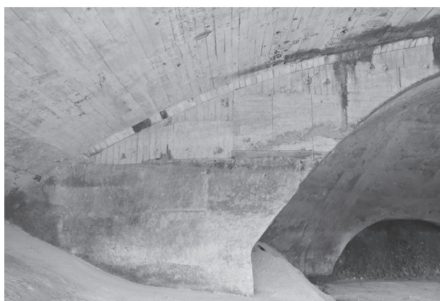
4. 掩体前部奥壁に見える工法の違い 上部が Z6 工法、下部が Z5 工法
