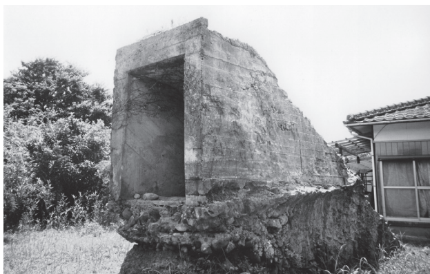
1. 地下通信司令部壕跡(東側出入口)
