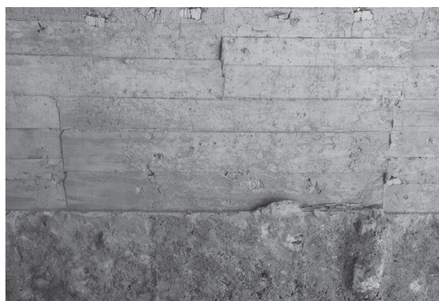
5. 掩体前部側壁に見える工法の違い 上部が Z6 工法、下部が Z5 工法
