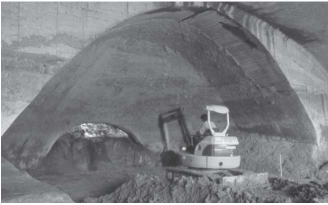
1. 後部の開口部から流入した土砂の除去
