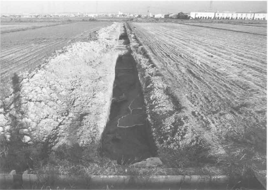
F調査区全景 (西端 (F-0付近) より撮影)
