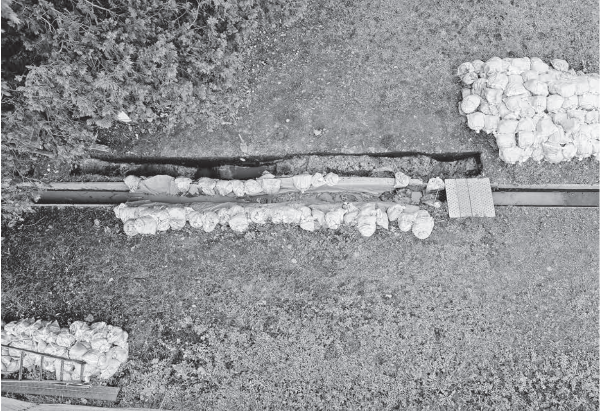
北側調査区 全景（直上から）
