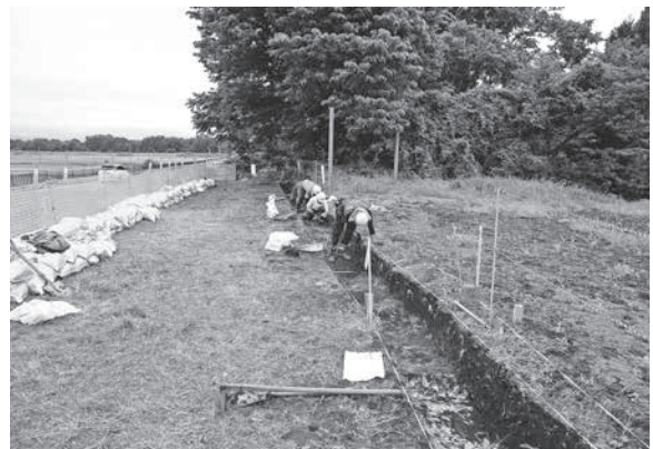
南側調査区 作業風景 (北西から)
