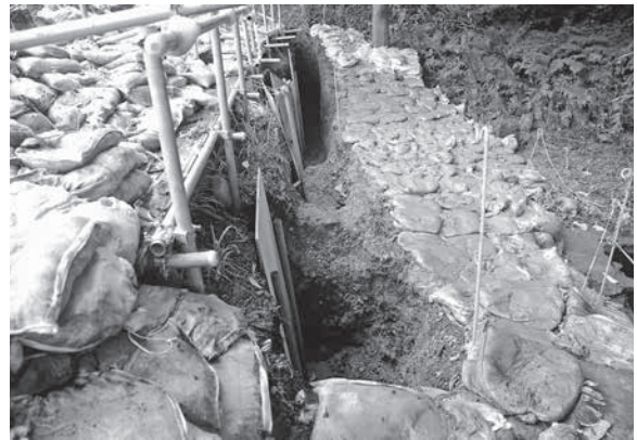
南側 全景 (北から)
