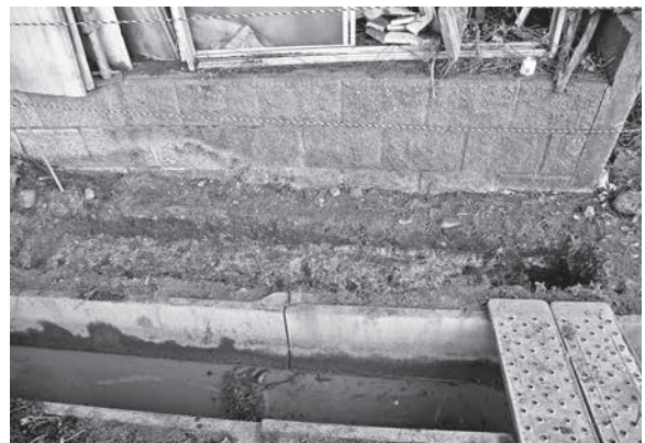
SDⅢ堀 (南側) 断面 (北東から)
