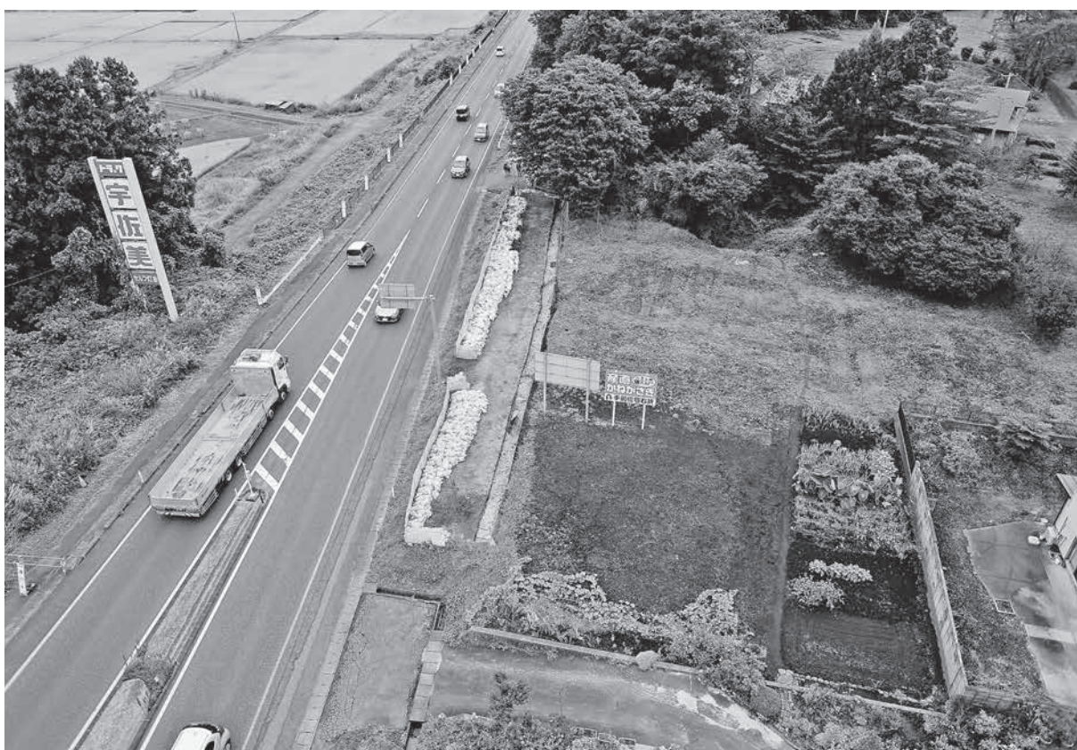
調査区 近景（北西から）
