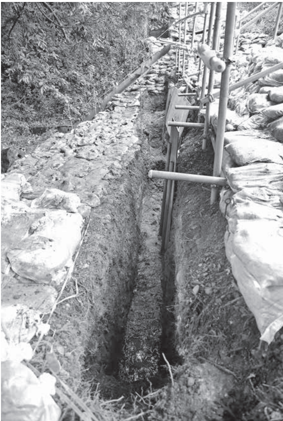
南側 全景 (南から)
