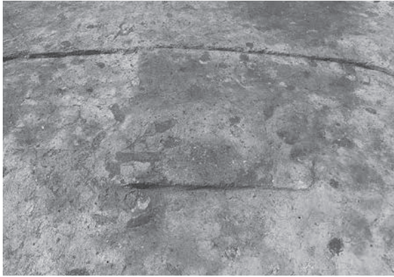
SI02カマド燃烧部
