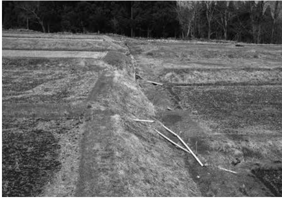
現況（南東から）
