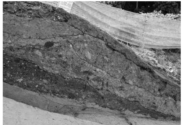
SX01 断面 (南東から)
