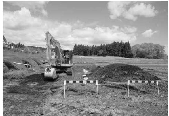
7区 作業風景 (南東から)
