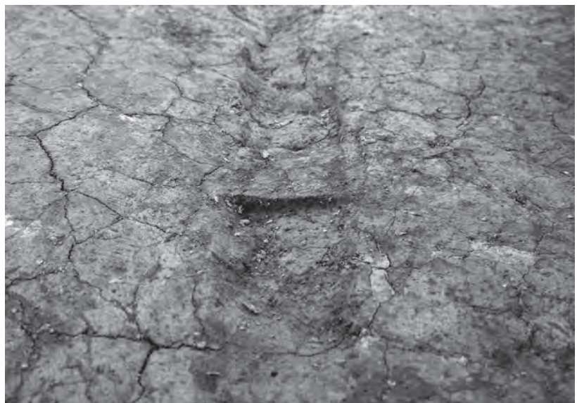
間仕切溝断面（北から）
