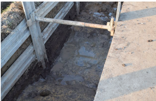
SD411 (南東から)
