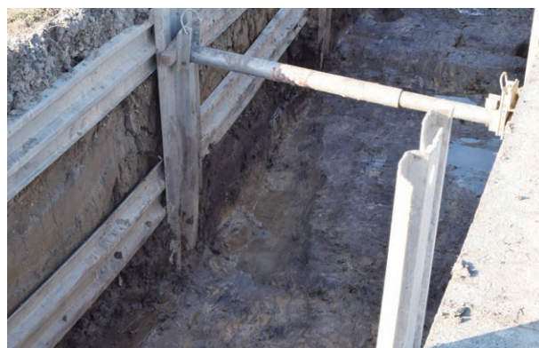
SD408 (南東から)
