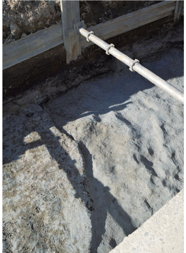
SD603・604 (南東から)
