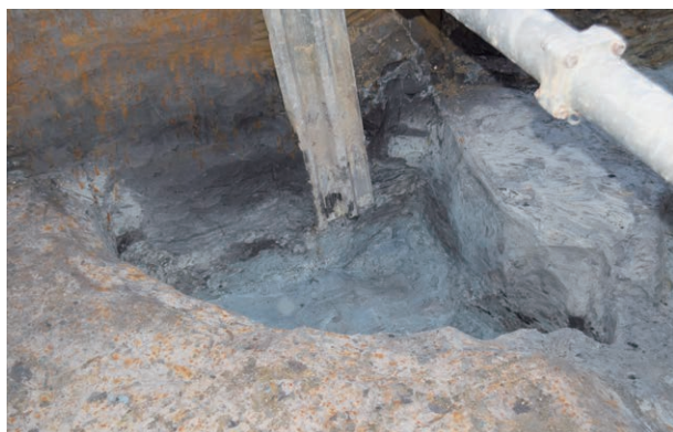
SK611 (南東から)
