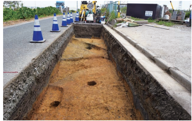
B13・14区全景(西から)
