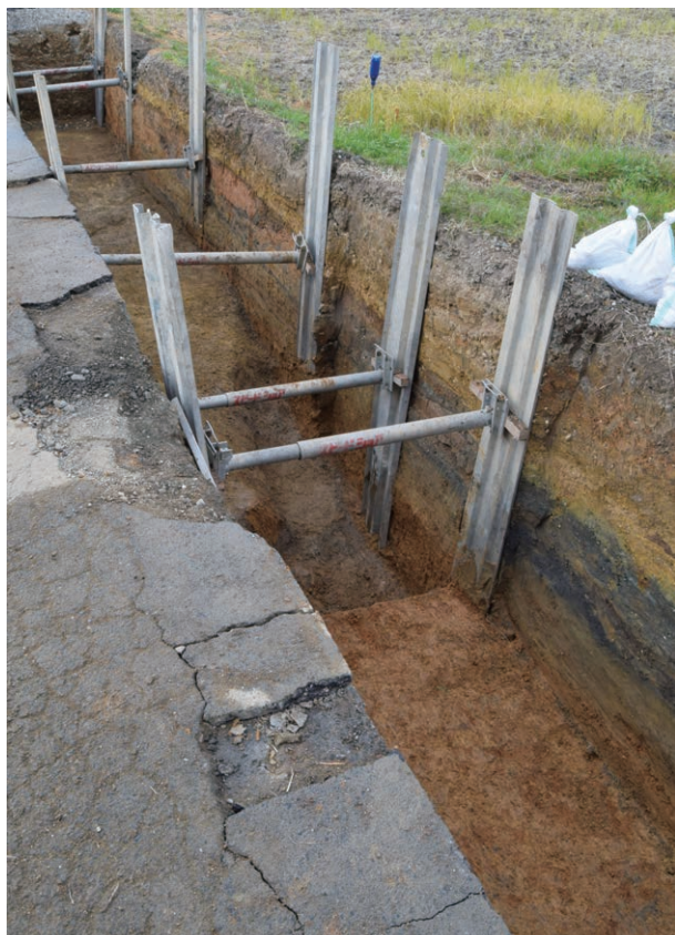
SD707 (南東から)
