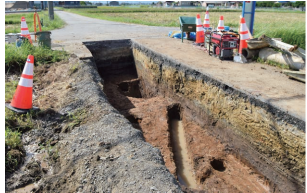
SD102 (南東から)
