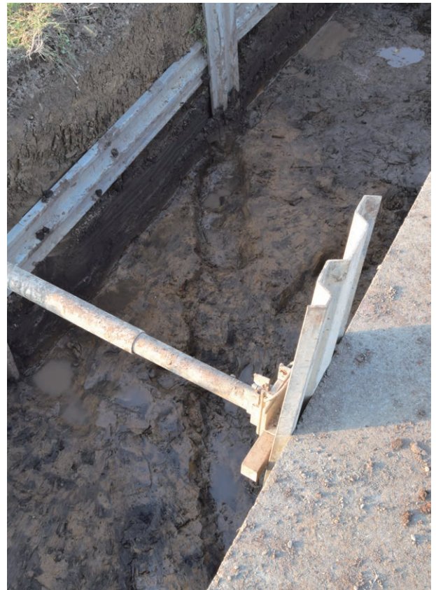
SD412 (南東から)
