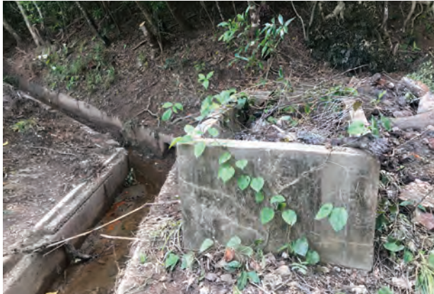
③ コンクリート側溝横のコンクリート柵跡
