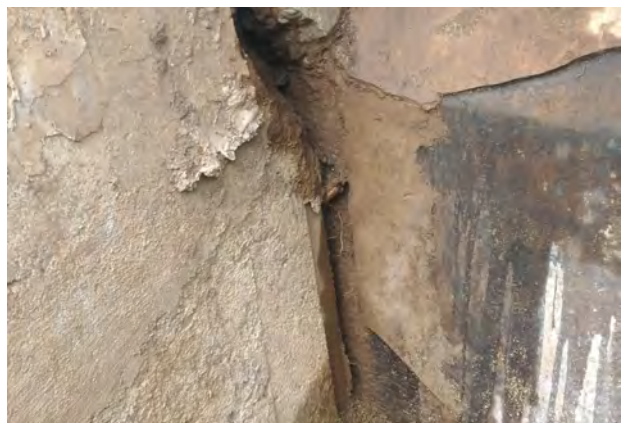
⑤ 擁壁接続部
