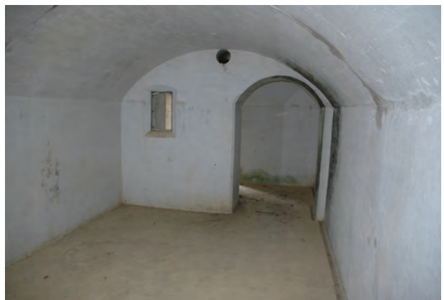
⑧ 第2砲側庫跡 弾薬庫内部
