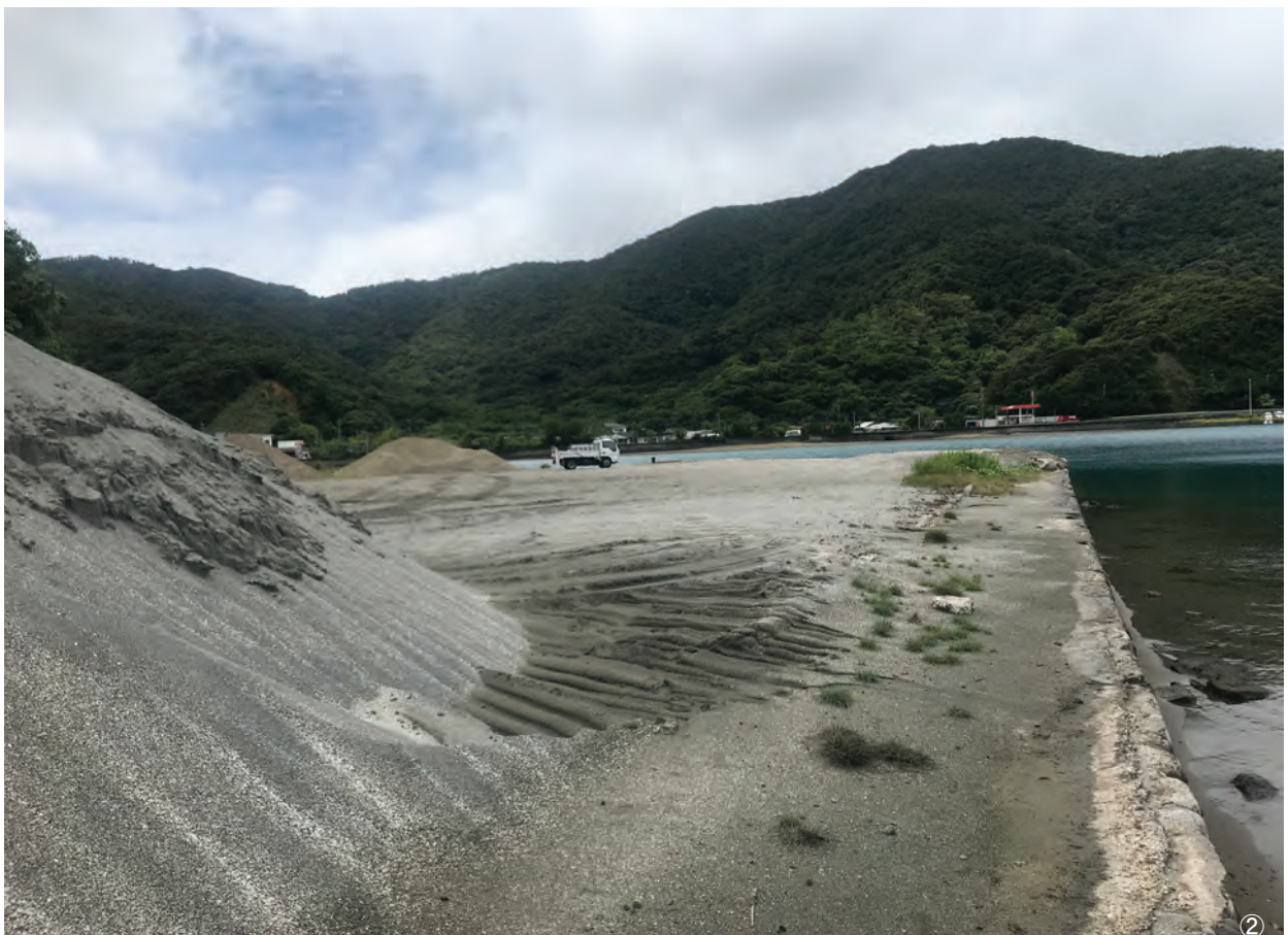
①艦艇接岸壁古写真「1946/5/5 加計呂麻島 246821」一部改変（米国国立公文書館所蔵） ②艦艇接岸壁現況
