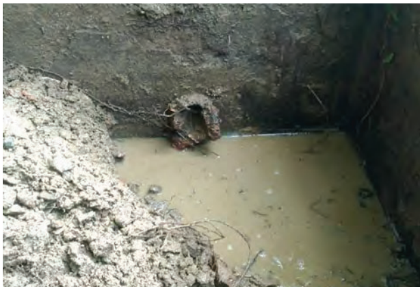
⑦ 濾水池配水管跡
