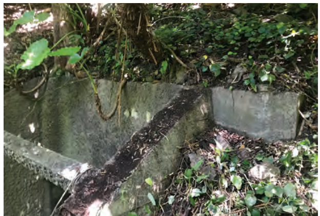
⑧ 第3弾薬庫跡入口上部の梁
