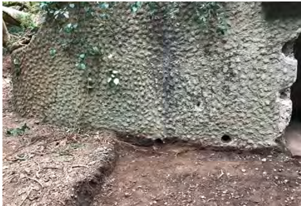
② 排水孔跡及び換気孔跡（外側）
