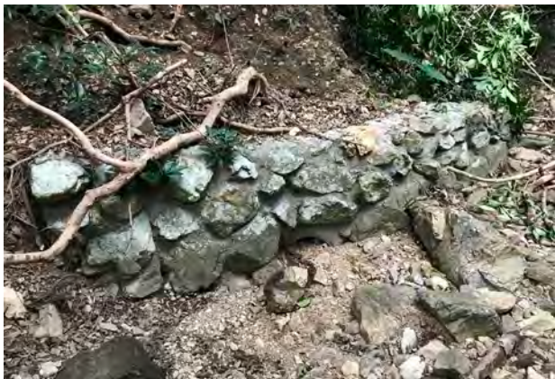
⑤ 第2砲座跡東の排水施設
