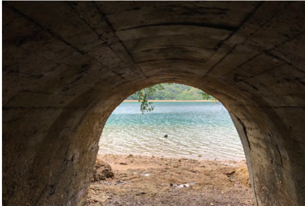
③ 第1格納壕跡 内部コンクリート
