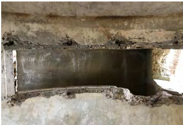
⑤ 第1観測所跡観測部から見た増築部分
