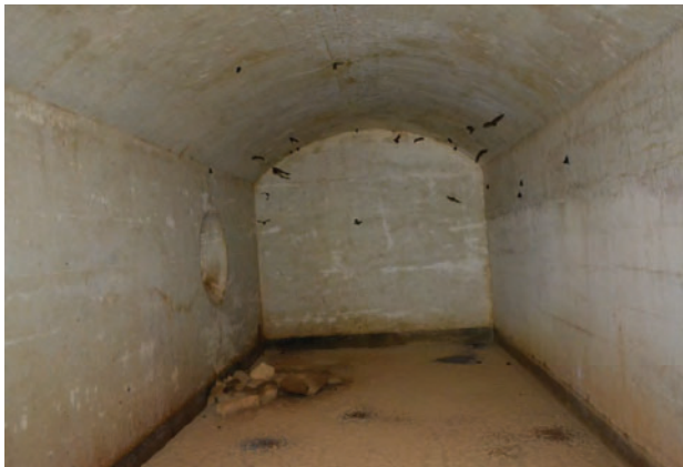
⑤ 弾薬庫跡内部
