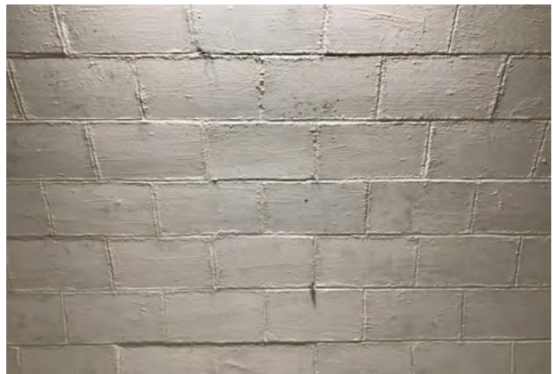
② 連絡通路跡 天井部コンクリートブロック巻き
