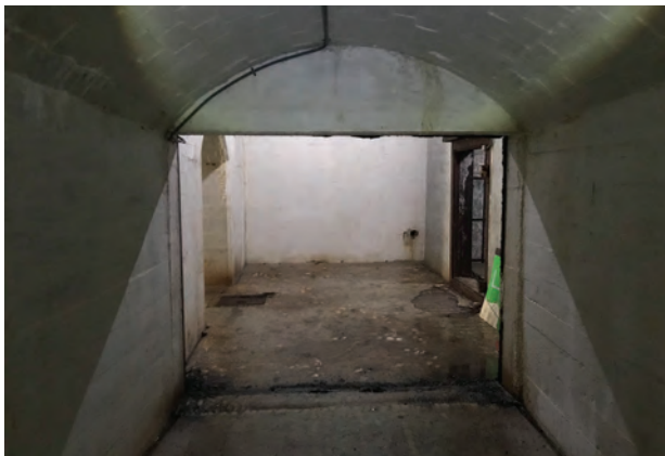
① 連絡通路跡入口金属製扉枠及び鴨居状コンクリート
