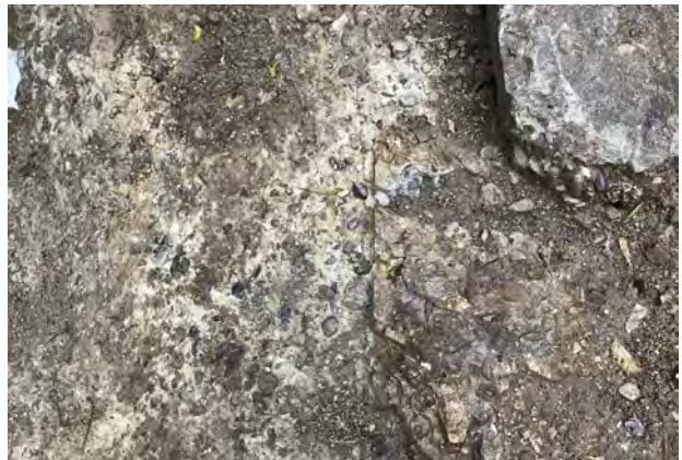
③ 第2砲座跡砲座コンクリート混和剤
