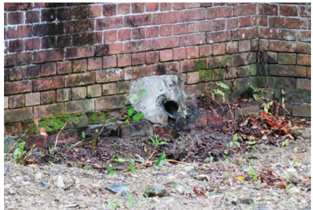
④ 水溜跡南側中央桁下部の穴 1
