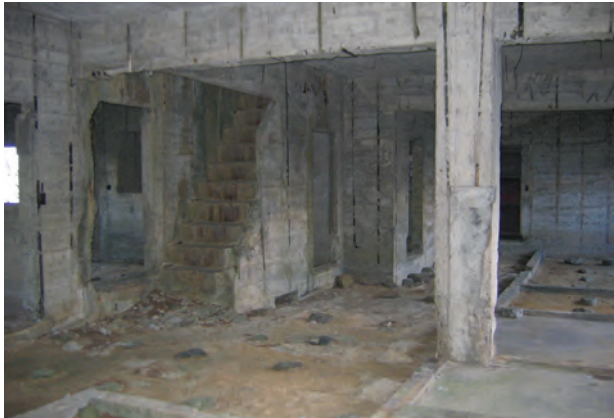
② 衛所跡 1階通路
