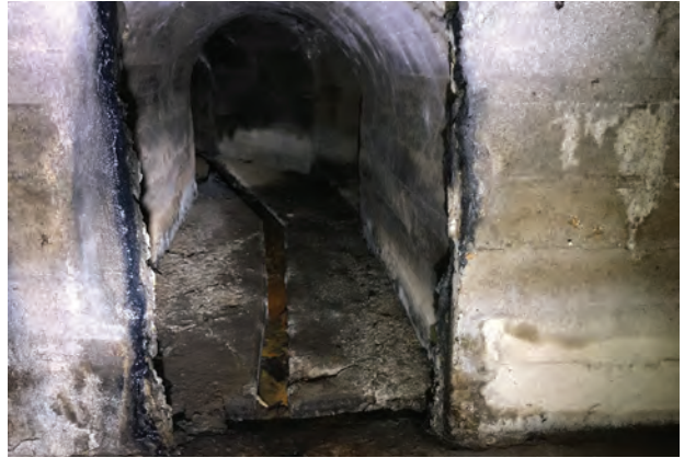
④ 第2防空壕跡内部1
