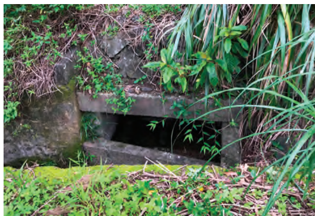
③ 第1弾薬庫跡 排水口
