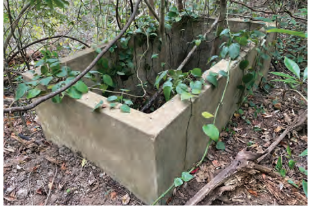
④ 病室と階段の間のコンクリート柵
