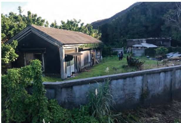
⑦ 監守衛舎跡
