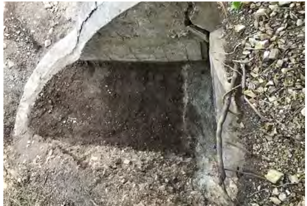
③ 排水砂検出状況
