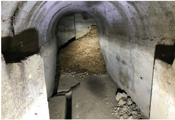
⑤ 第2防空壕跡内部2
