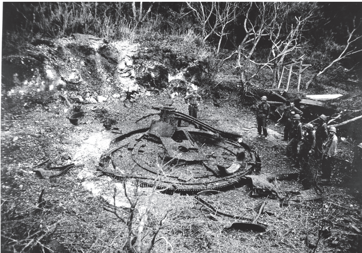
写真 13 榴弾砲破壊状況 2 「1945/10/6 Nishikoma-jima 249537」一部改変 (米国国立公文書館所蔵)
