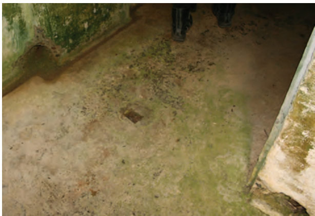
⑦ 第2砲側庫跡 弾薬庫入口付近のドア痕跡
