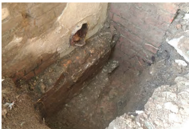
⑤ 水溜跡南側中央桁下部の穴 2
