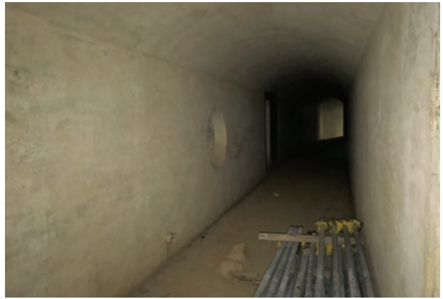
④ 内部通路2
