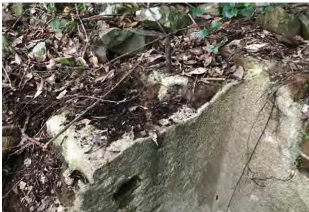
⑤ 濾水池上部鉄筋及び配水管跡
