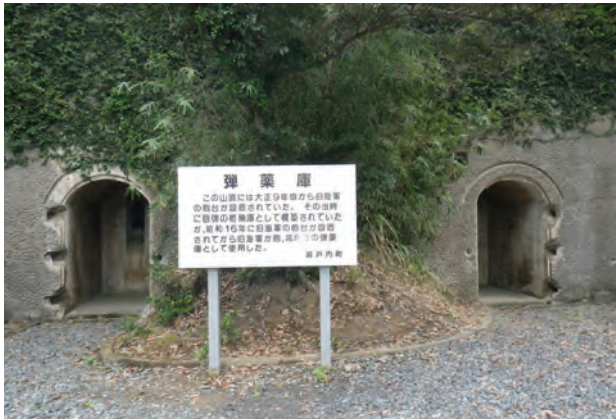
⑤ 第1砲側庫跡 入口
