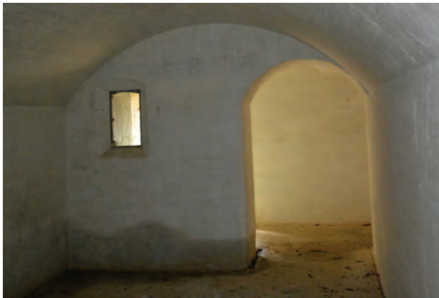
⑦ 第1砲側庫跡 弾薬庫内部
