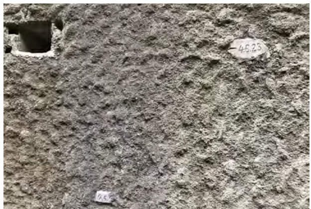
⑤ ドイツ壁表面のコンクリート
