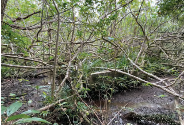
① 第2不明コンクリート基礎跡
