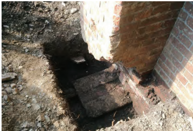
① 水溜跡補強柱内部構造
