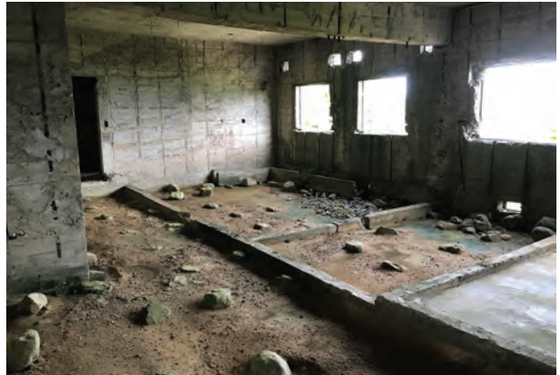
③ 衛所跡 1階居住区
