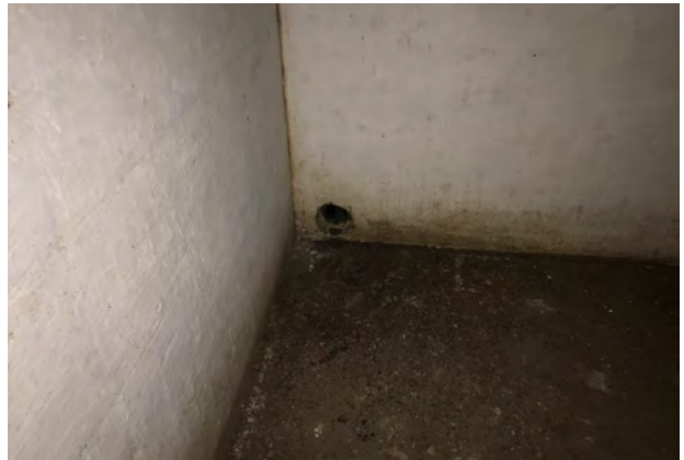
③ 換気孔跡（内側）
