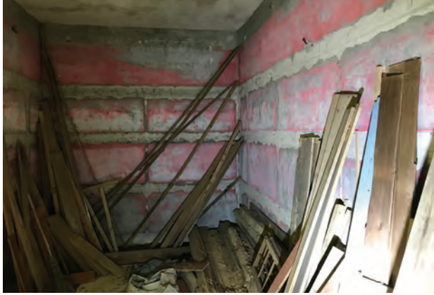
① 衛所 1階蓄電池室跡
