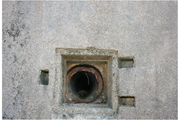
④ 第2砲側庫跡 吸排気孔
