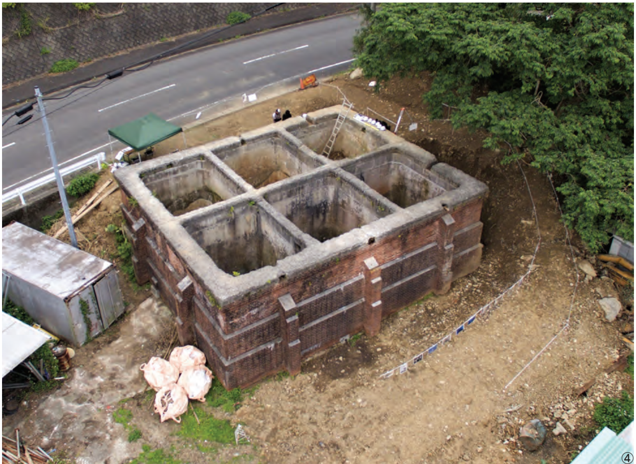
①取水口跡近景 ②取水口跡レンガ構造物 ③濾水池跡近景 ④水溜跡近景
