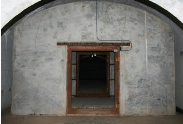
③ 第2弾薬庫跡 内庫前室入口
