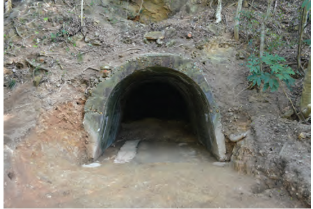
② 第4格納壕跡入口（発掘調査後）
