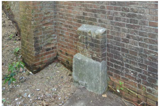
② 水溜跡西壁給水管
