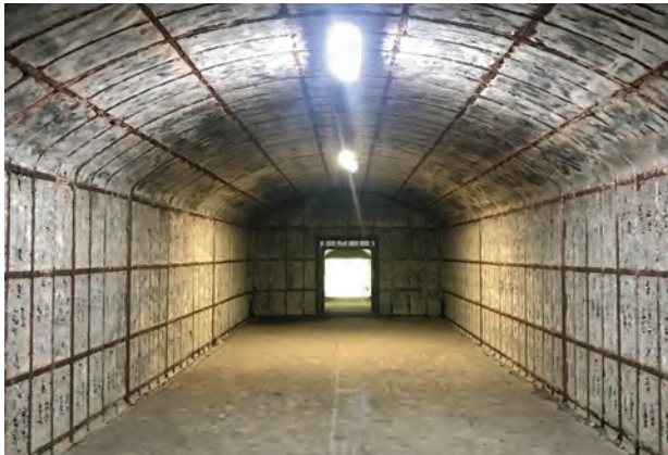
⑤ 第2弾薬庫跡 内庫本室内部構造
