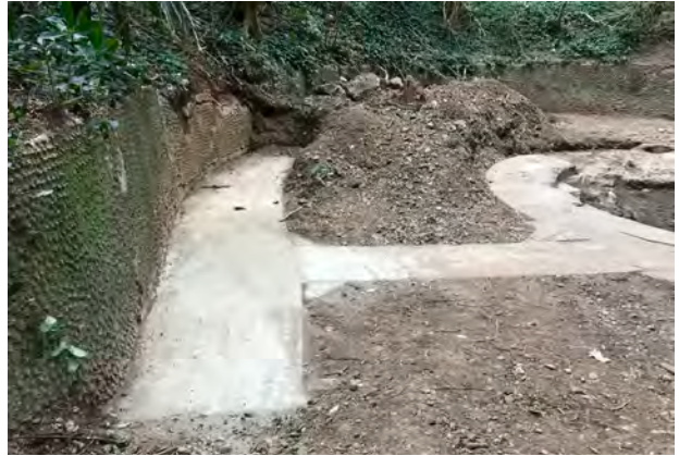
② 第2砲座跡弾薬運搬通路2
