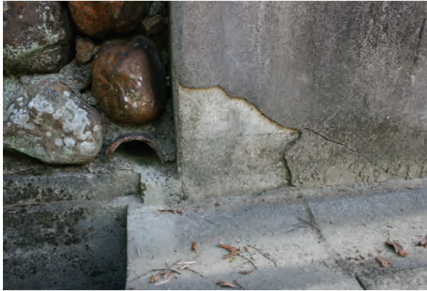
③ 第2砲側庫跡 排水孔
