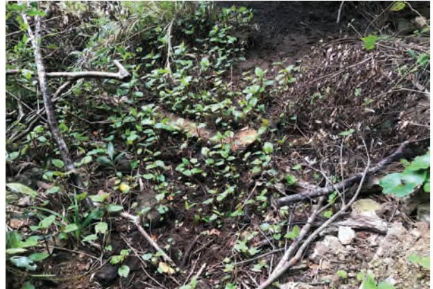
④ 兵舎コンクリート基礎跡
