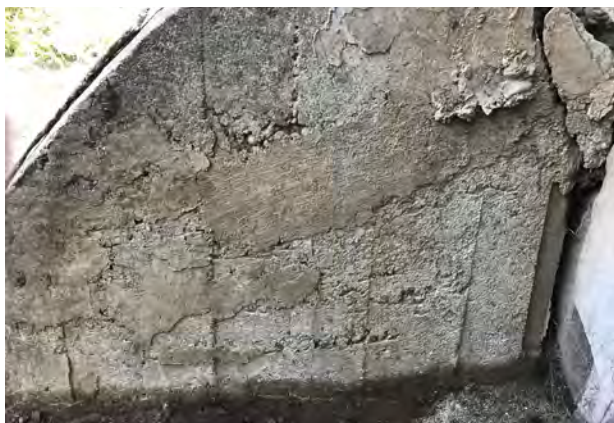
④ 擁壁内面状況
