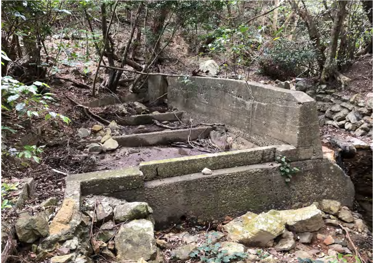
① 沈殿池跡
