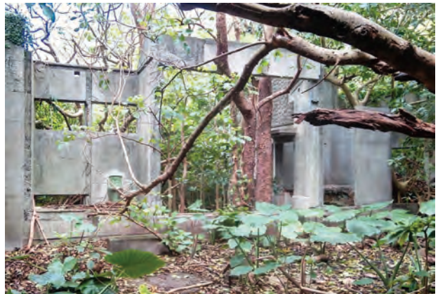
⑥ 監守衛舎跡内部
