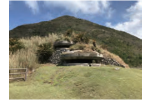
観測所窓 外部
