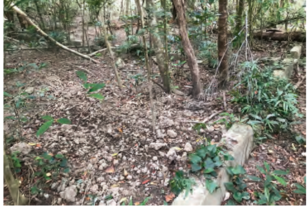
② 病室コンクリート基礎跡
