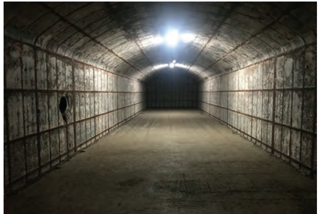
⑥ 第3弾薬庫跡 内庫本室内部構造
