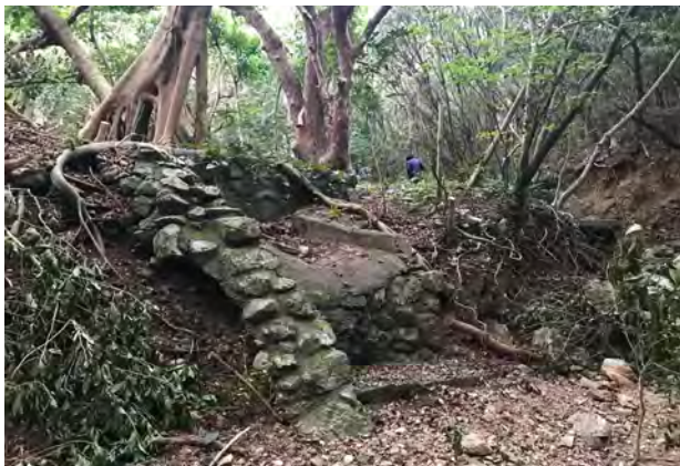
④ 井戸跡排水施設
