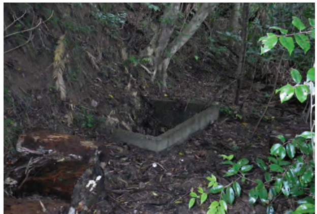
④ 不明コンクリート基礎1
