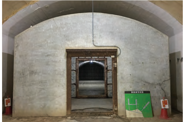
④ 第3弾薬庫跡 内庫前室入口
