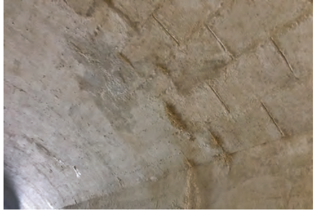
② 第3弾薬庫跡通路 天井部
