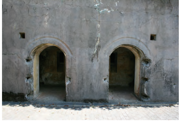
② 第2砲側庫跡 入口
