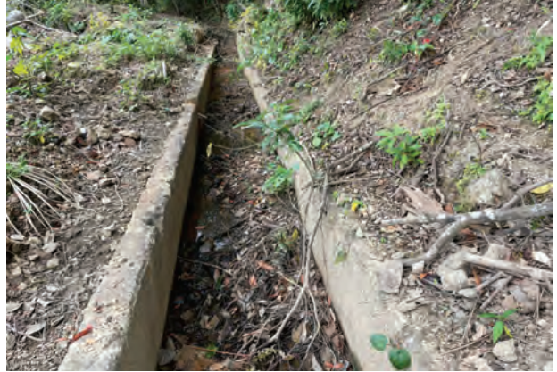
② コンクリート側溝跡
