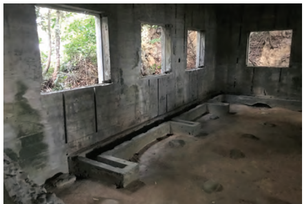
⑤ 衛所跡 配線溝
