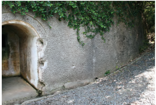
⑥ 第1砲側庫跡 排水孔
