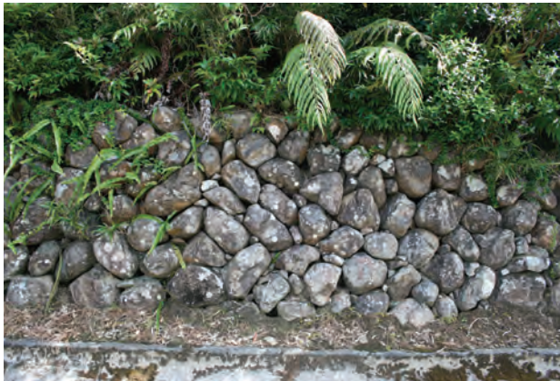
⑤ 円礫による擁壁
