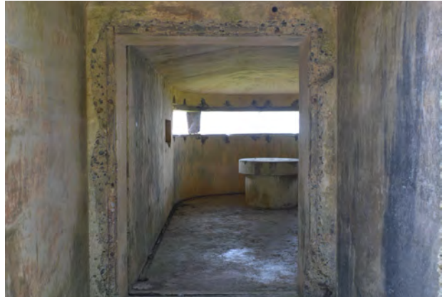
③ 入口の扉跡
