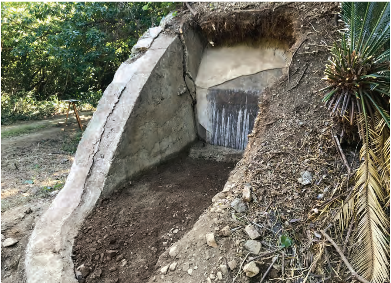
①第2砲側弾薬庫跡外観 ②第2砲側弾薬庫跡発掘調査
