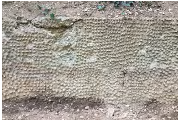
④ 第2砲座跡擁壁ドイツ壁
