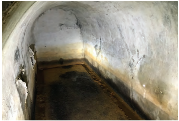
⑥ 第2防空壕跡内部3
