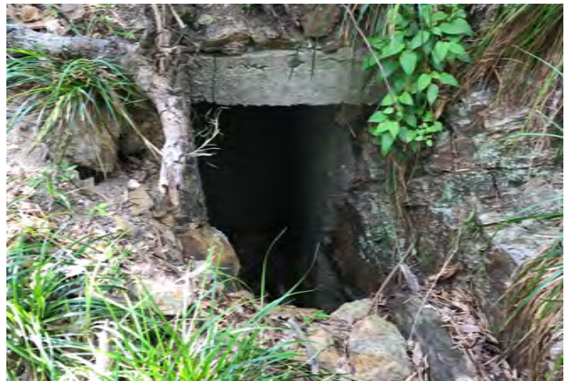
④ 第1観測所跡増築部分入口
