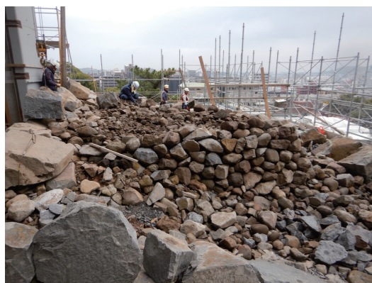
小守石垣積み直し作業状況
