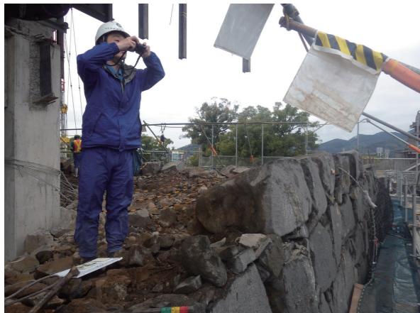
⑤ 築石石材調査 石垣の積み方を把握するために調査、記録します。
