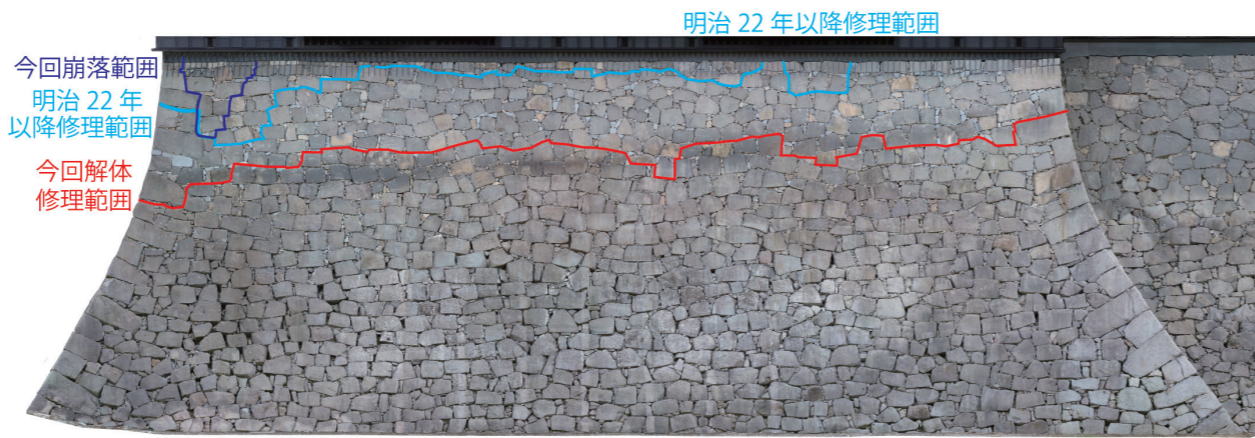
H513 修復履歴図 (復旧完了後)
