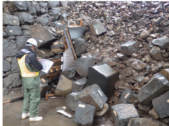
① 崩落石材番付作業 崩落した石材に番付し、位置を記録します。
