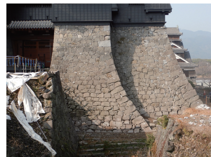
小天守石垣東面(H509・H511)復旧完了状況(東から)
