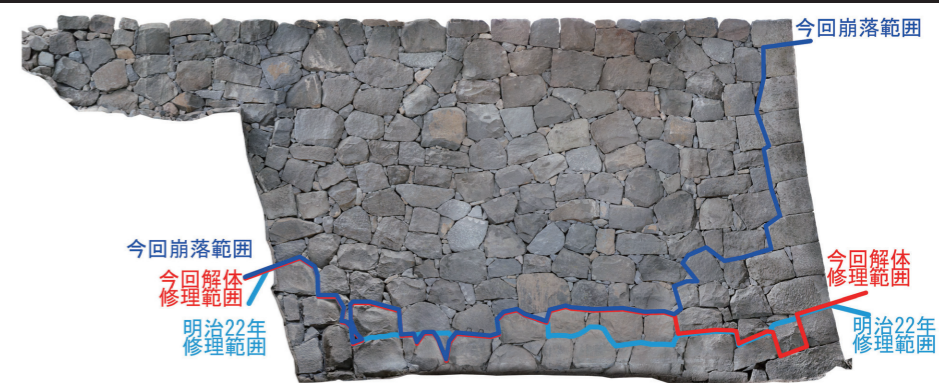
H507 修復履歴図 (復旧完了後)
