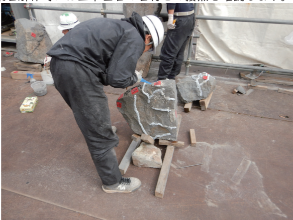
⑥ 築石石材補修作業 割れている石材を接着し、再度積み直しています。
