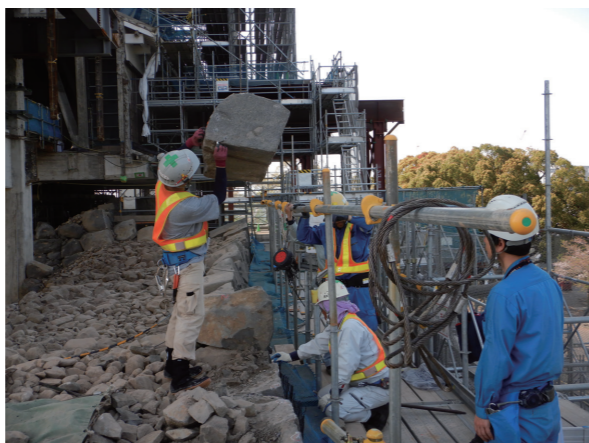
④ 石垣解体作業（築石） 築石解体時には上下左右の石材との接点を確認します。
