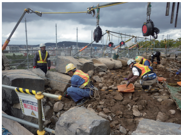
③ 石垣解体作業（裏込め） 一段ごとに回収する築石に合わせ、裏込めを解体します。
