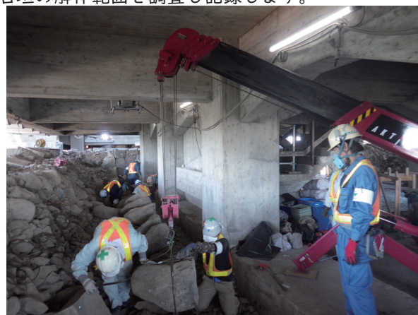
③ 石垣解体作業（築石） 大天守穴蔵内部は狭く、解体作業は難航しました。
