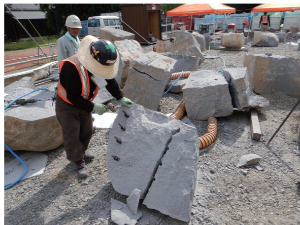
⑥ 築石新補石材加工作業 ※新材確保地は調査に基づき厳選。 損傷がひどく、再利用できない石を新材で補います。
