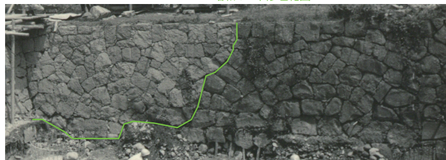
H618-1 昭和 35 年工事写真
