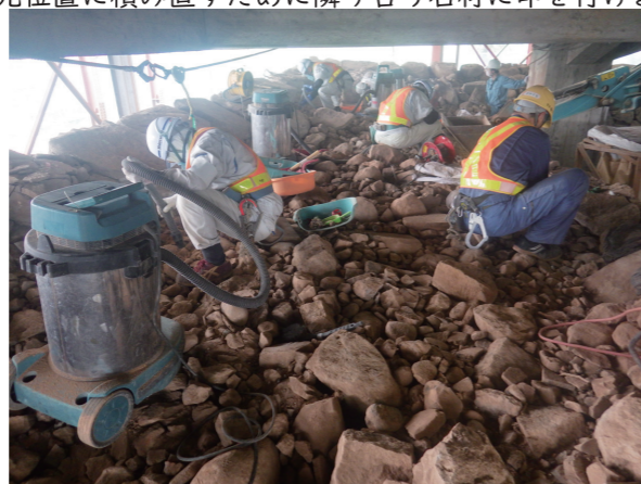
④ 裏込め清掃作業 解体途中で清掃作業を行ない、石の積み方等を記録します。
