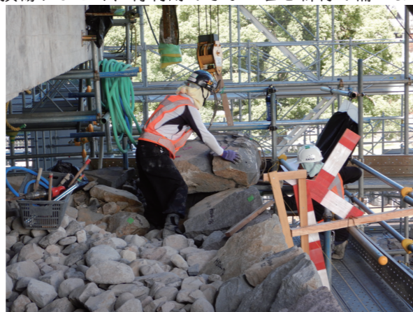
⑧ 積み直し作業（築石） 解体前の写真等を参考に築石を積み上げます。
