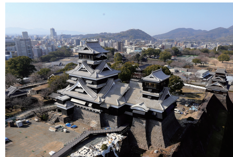
大小天守石垣復旧完了状況（東北東から）
