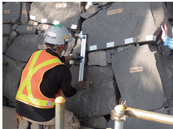
② 石垣墨打ち・番付作業 元位置に積み直すために隣り合う石材に印を付けます。
