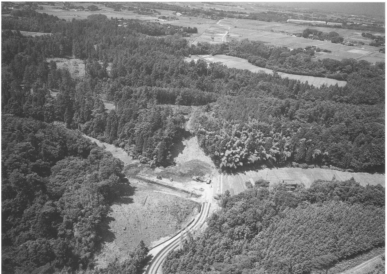
2. 調査区遠景（北から）
