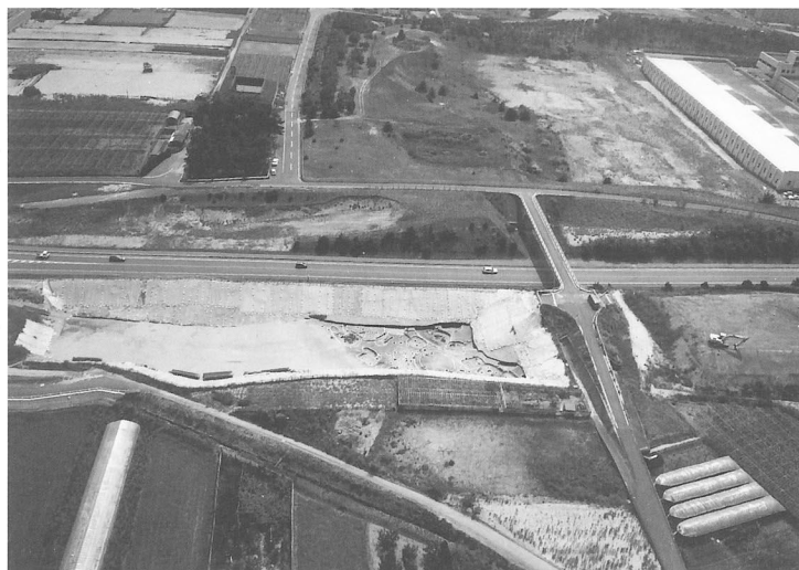
長瀬高浜遺跡古墳時代集落完掘状況（北上空から）
