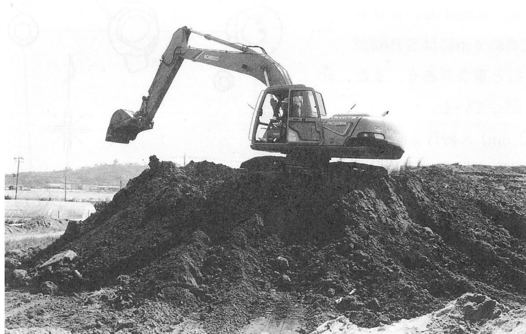
文中写真② 重機表土剥ぎ作業風景
