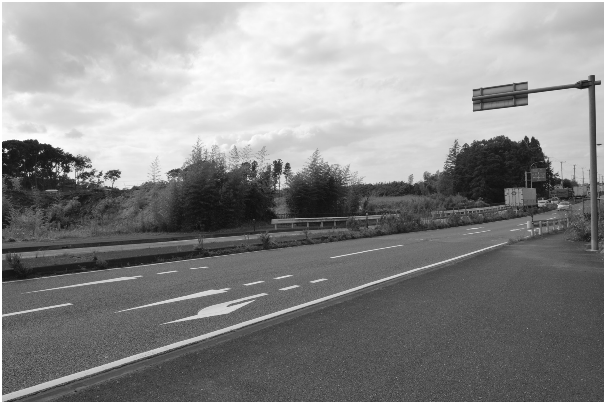
1. 遺構全景（北東から）
