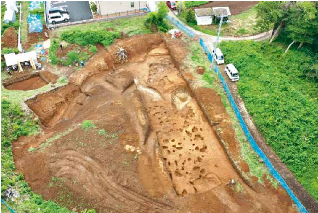
調査区全景(南西から)
