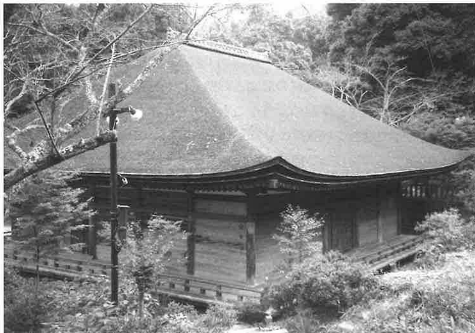
写真1 長寿寺本堂（湖南市）
