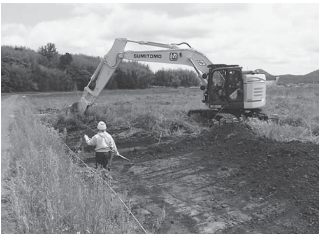
写真1 山ノ下遺跡 表土剥ぎ風景
