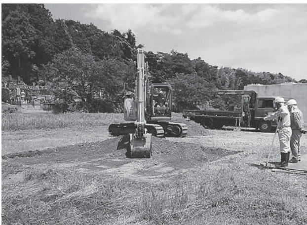
写真3 平ノ前遺跡P3区 表土剥ぎ風景
