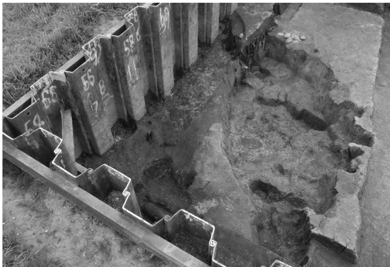
4 8溝杭列群取り上げ状況（西から）
