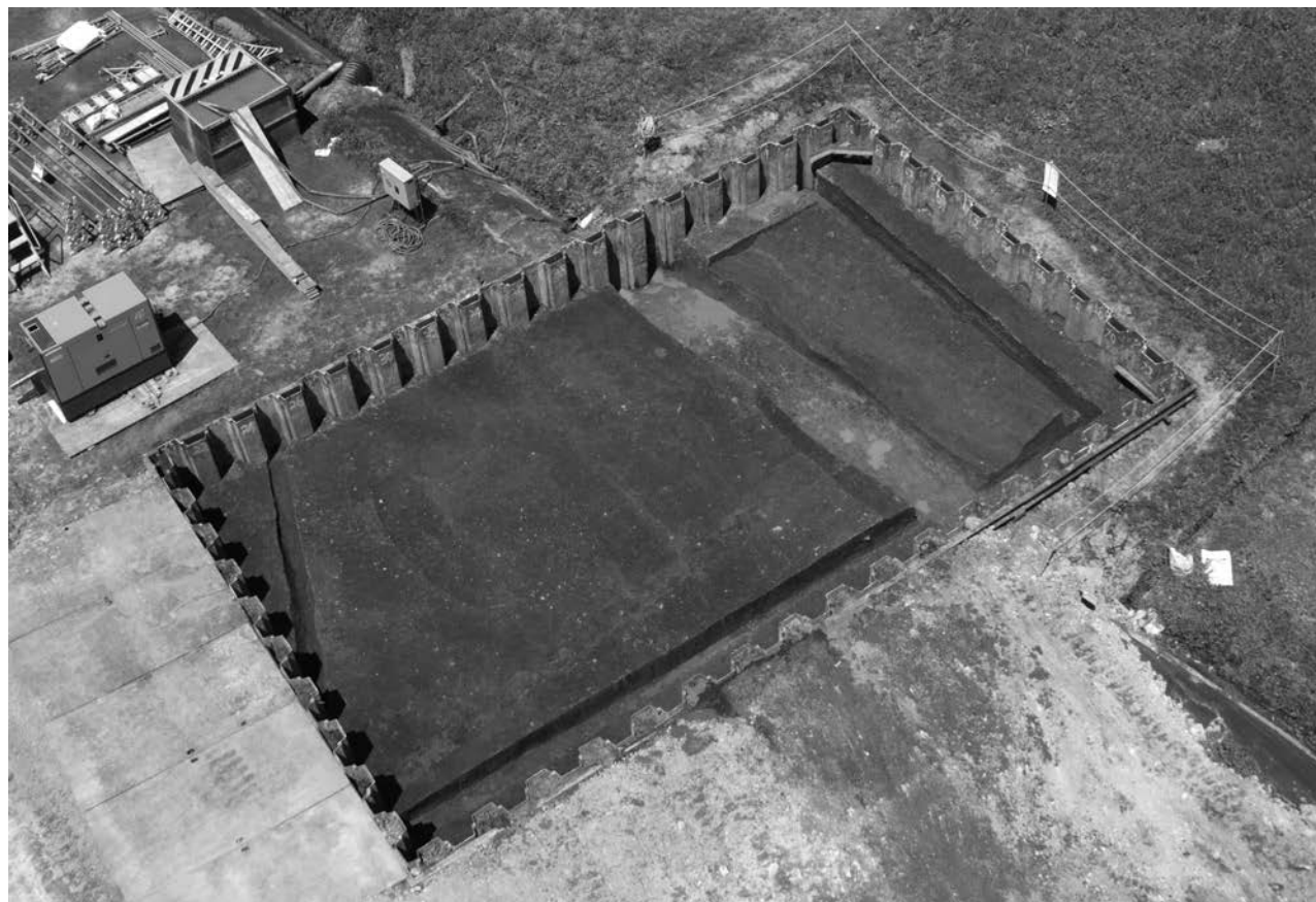
1 第1遺構面完掘状況（南東から）
