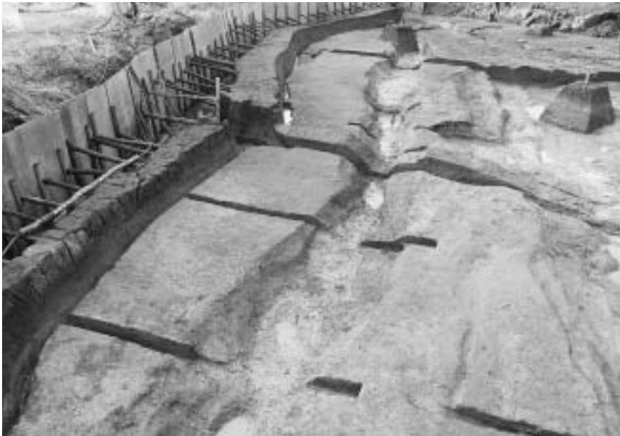
1. SD14完掘状況 (南東から)
