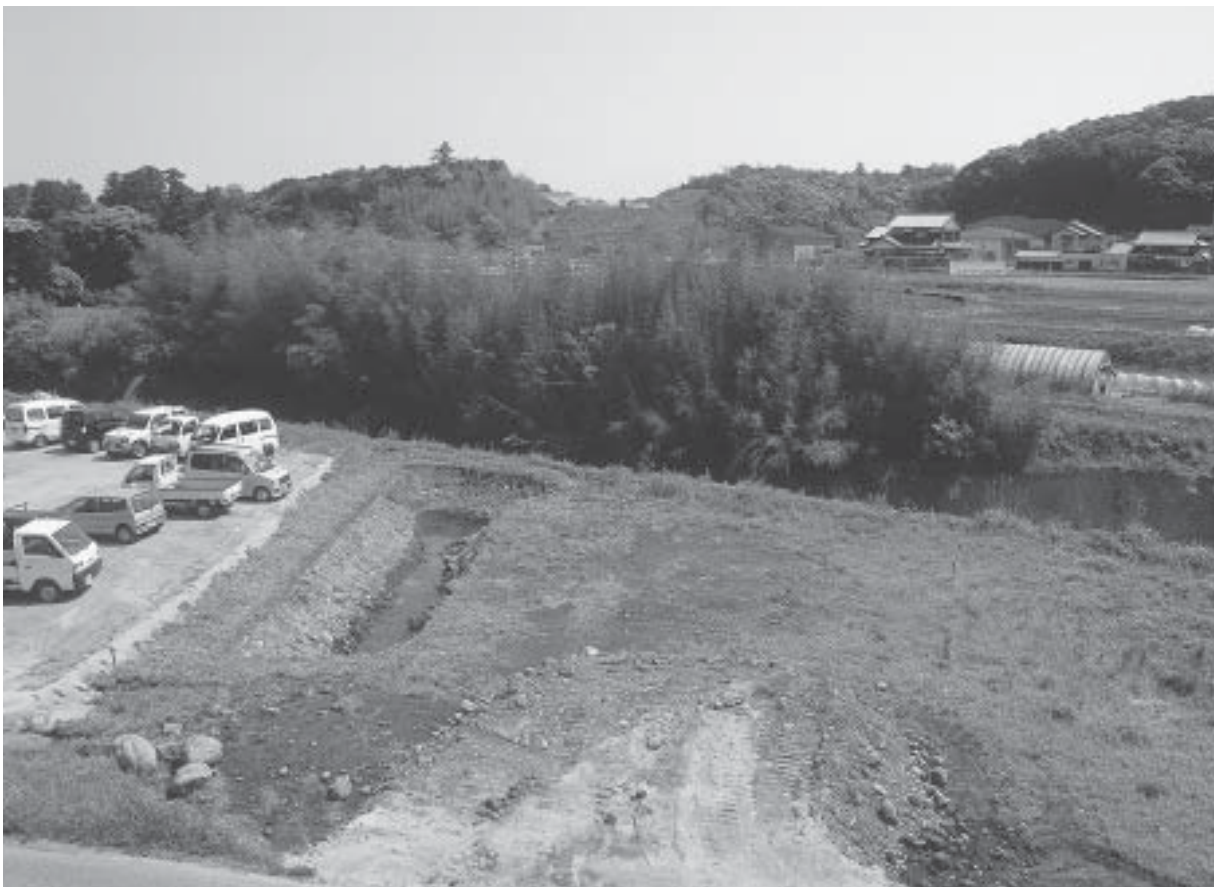
2 1区完掘状況（南西から）
