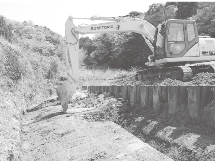
3 機械掘削状況（北西から）
