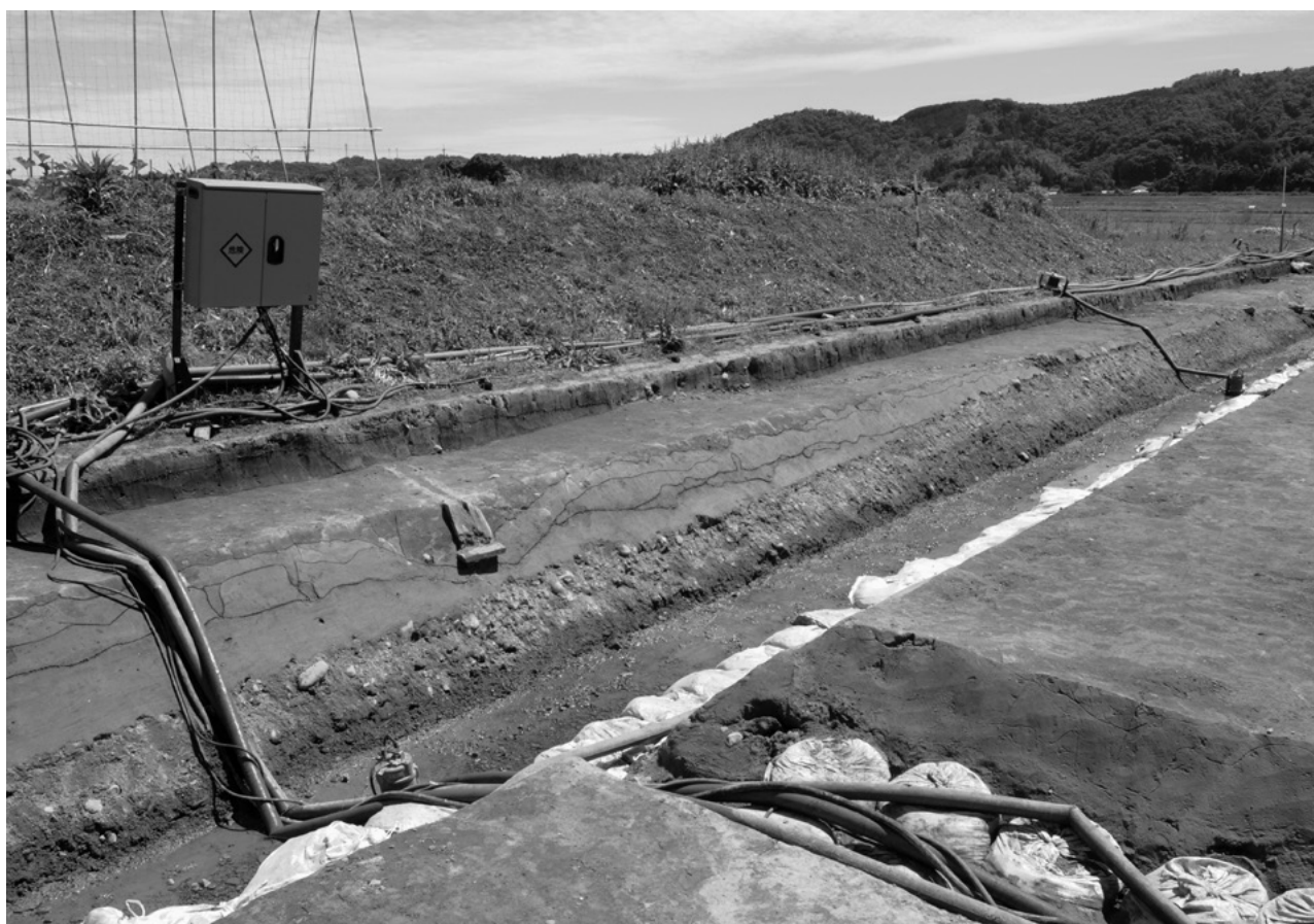
2. 北壁土層断面(3) (Y=-23,580~-23,600間 南西から)
