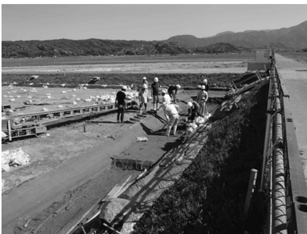
写真9 作業風景(西側溝掘削)
