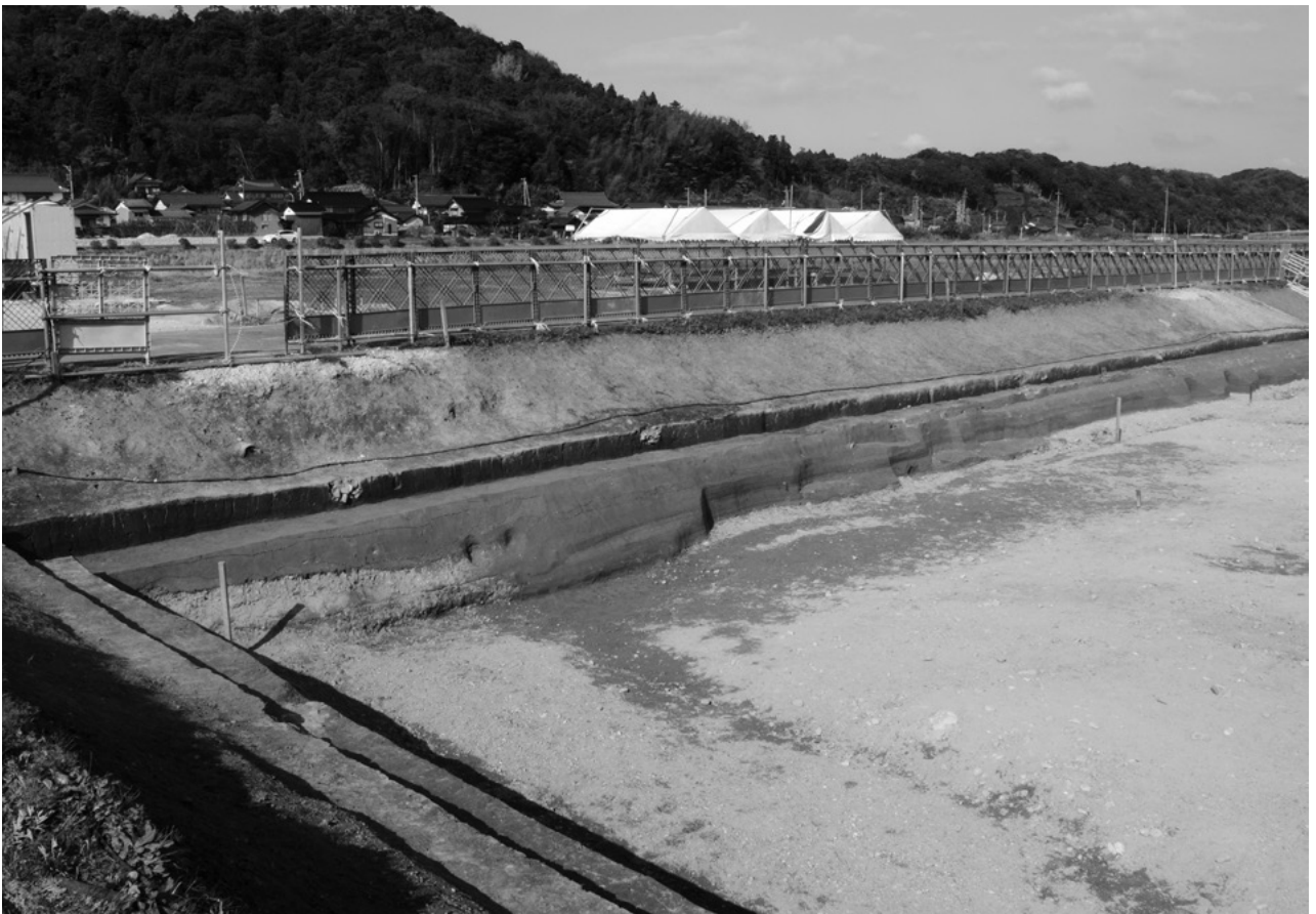
2. 西壁土層断面(1) (X=-55,300~-55,322間 南東から)
