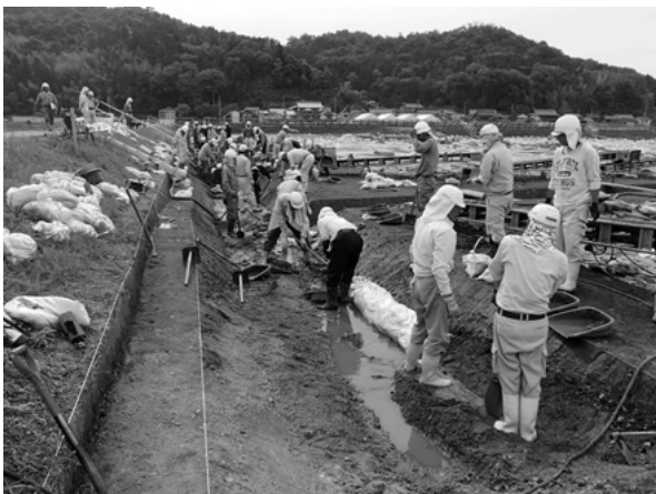
写真7 作業風景(南側溝掘削)
