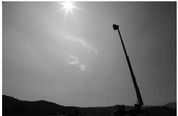
写真8 作業風景(高所作業車による撮影)
