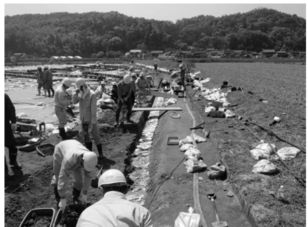
写真 6 作業風景 (北側溝掘削)
