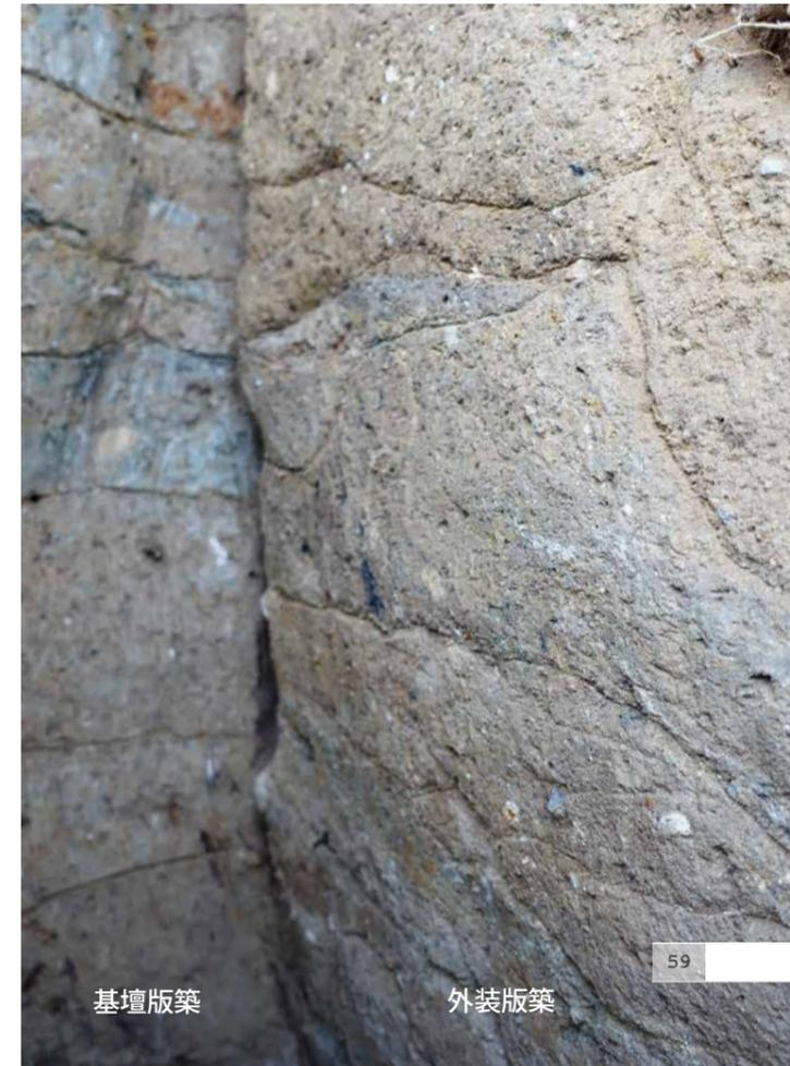
写真67 金堂基壇版築と乱石積による版築 (第11次北西から)
