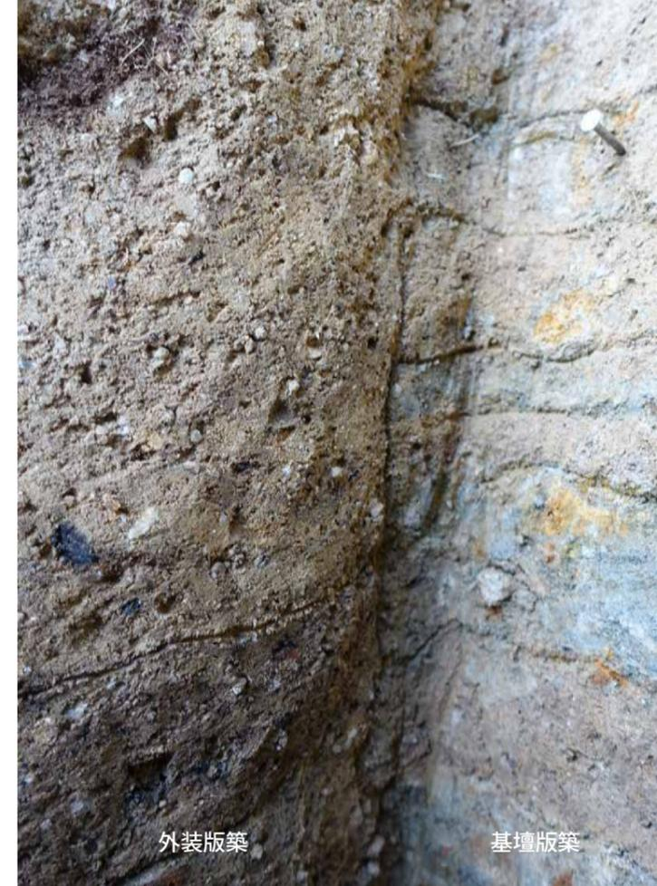
写真66 外装改修による基壇版築の切断部 (第11次北東から)
