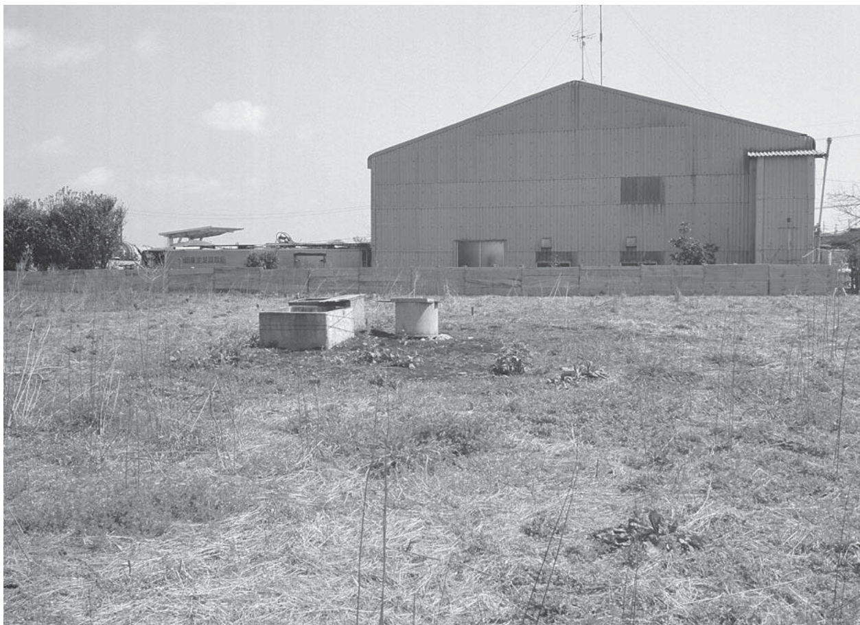
1. 調査前（西から）
