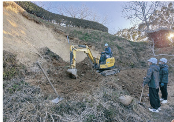
復旧工事の様子
