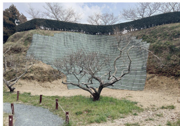
西の丸復旧工事の完了状況
