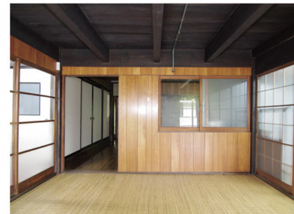
工事前の主屋内部
