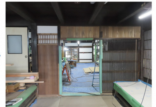
復元整備が進む主屋内部
