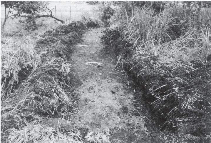
Aトレンチ調査状況 南から
