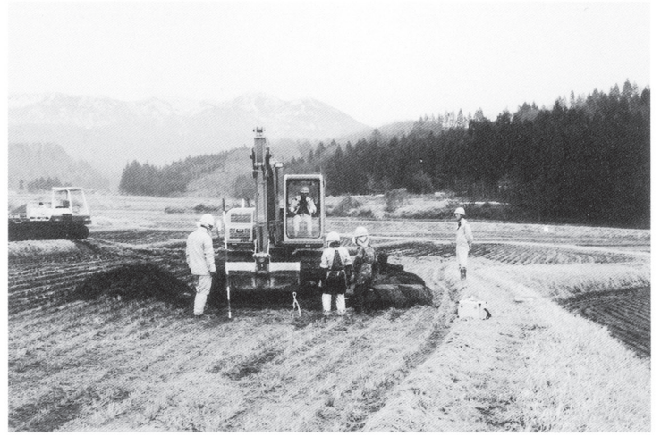
たて屋敷遺跡調査風景
