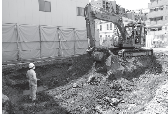
2. 重機掘削（北東から）
