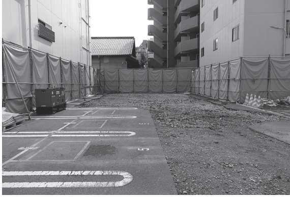
1. 調査前（西から）
