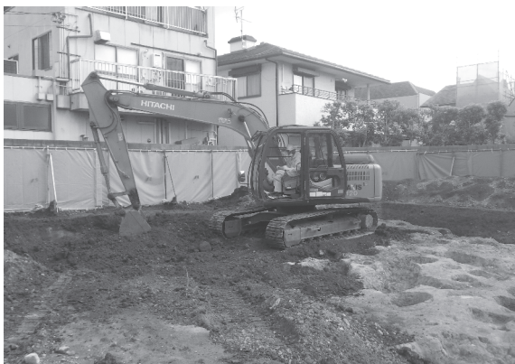
7. 埋め戻し作業（南西から）
