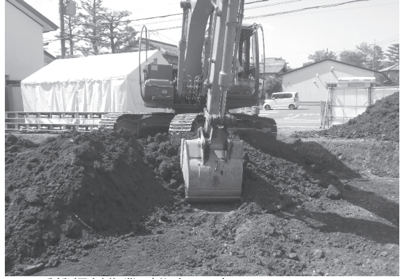
2. 重機掘削作業（北東から）
