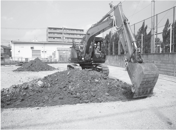
3. 重機掘削作業
