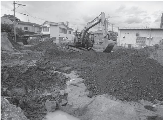
7. 重機による埋戻し作業
