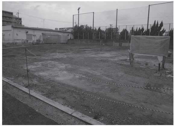
8. 埋戻し終了後（南東から）
