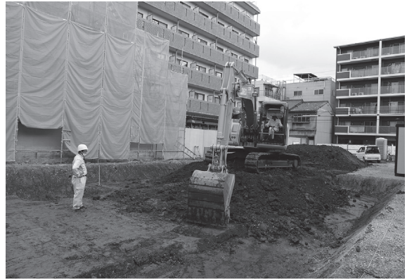
2. 重機による盛土掘削作業
