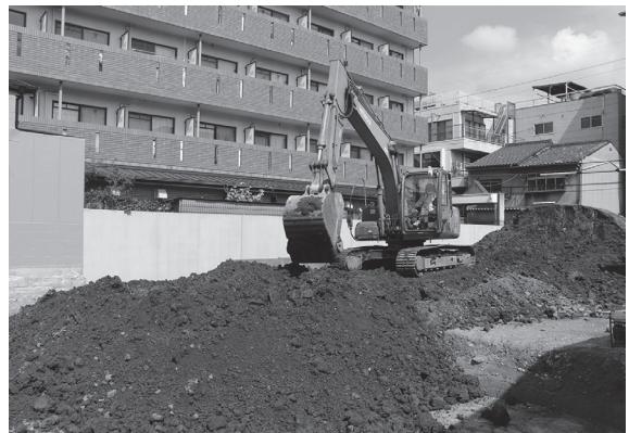
8. 重機による埋戻し作業
