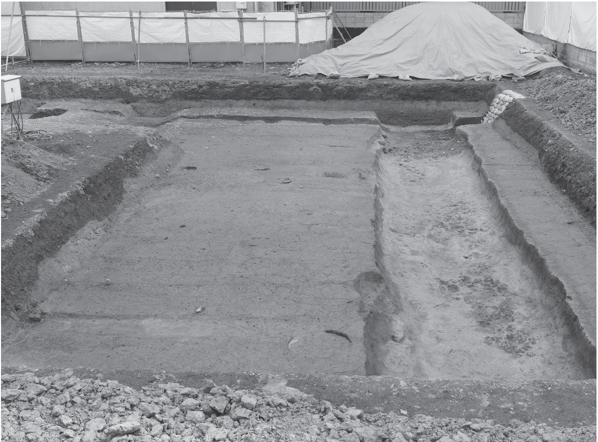
2. 第1面調査後の調査区南半（西から）
