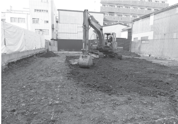
3. 重機による盛土掘削作業
