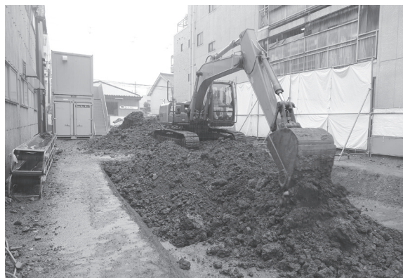
8. 調査完了後の埋戻作業（南から）
