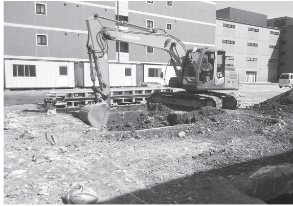
2. 北区重機掘削作業（北西から）
