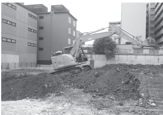
7. 南区埋め戻し作業（北から）
