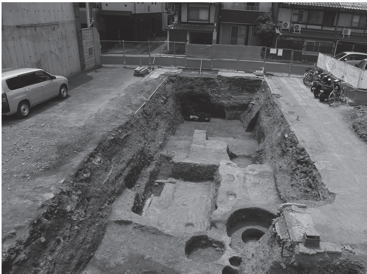
1. B区 3面全景（東から）
