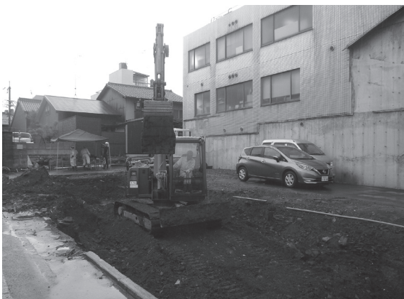
7. 埋戻しと転圧作業
