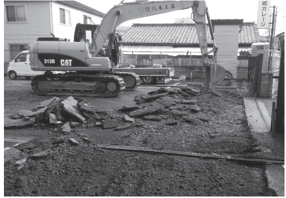
2. アスファルト撤去 (西から)
