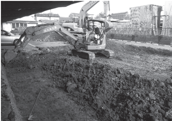
3. 重機掘削 (南西から)
