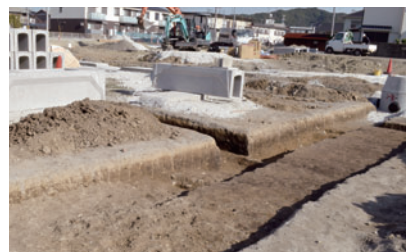
写真 20 SK19 断面（西から）
